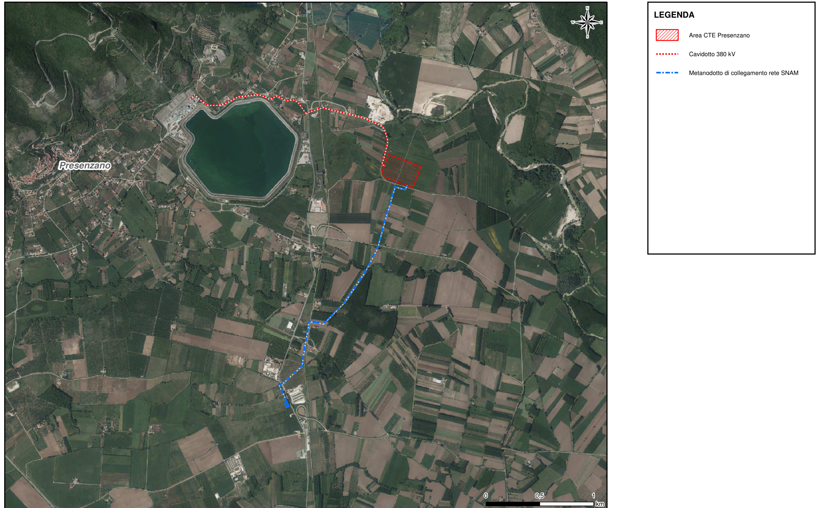
Figura 3.1a Sito della Centrale Edison di Presenzano ed opere connesse
