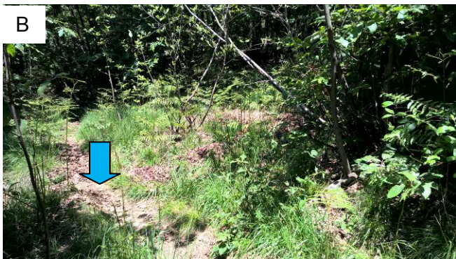
A – Area di fondazione nuovo sostegno (freccia rossa) e sentiero di accesso (freccia azzurra) B – Sentiero di accesso, con fenomeni erosivi legati a ruscellamento diffuso
