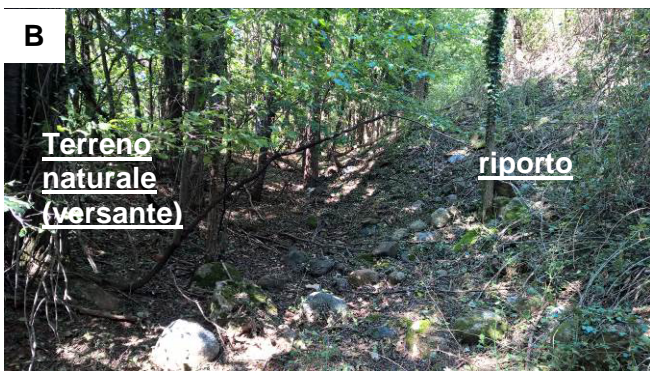
A – Area di fondazione nuovo sostegno (freccia rossa). La freccia azzurra indica la presenza di terreno di riporto (pietrame, probabile smarino) B – Contropendenza tra il riporto detritico e il versante. Presenza di numerosi blocchi decimetrici
