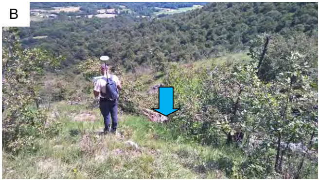
A – Area di fondazione nuovo sostegno (freccia rossa). Substrato roccioso affiorante. B - Rio con limitato trasporto solido (freccia azzurra)
