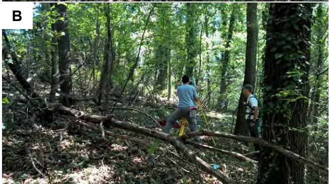
A – Area di fondazione nuovo sostegno (freccia rossa).
