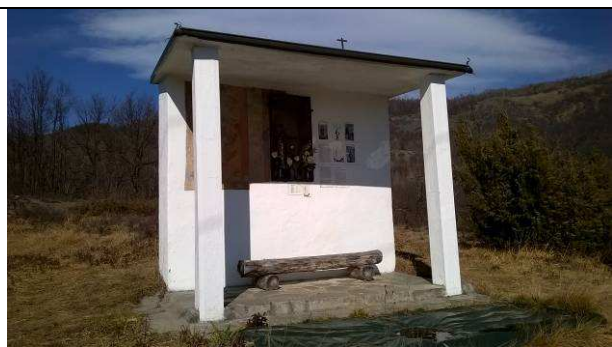
Fig.13: Il pilone di Sant'Aurisia, a 50 m dal sostegno 95
