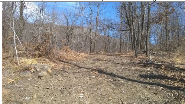
Fig.15: Area di edificazione sostegno 95
