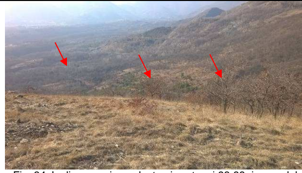
Fig. 34: La linea corrispondente ai sostegni 96-88 ripresa dal monte Giovetto
