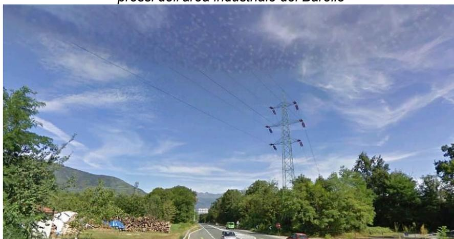
*Foto 21: tratto di linea di prevista dismissione in attraversamento alla strada provinciale delle Valli di Lanzo nei pressi dello svincolo per il centro abitato di Fiano (via Misti)*
