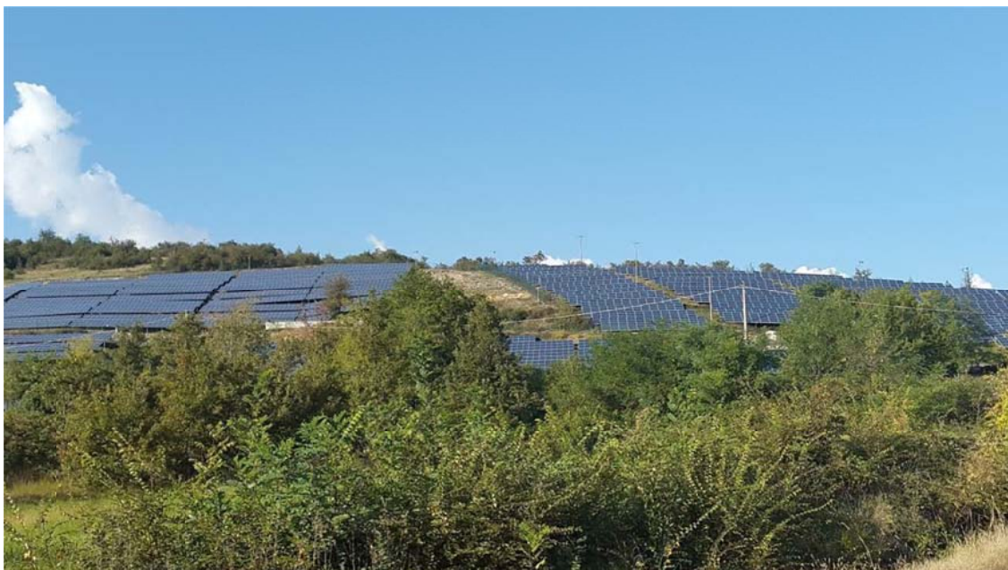
Figura 62: impianto fotovoltaico sul versante Sud del Monte Giovetto quale elemento detrattore
