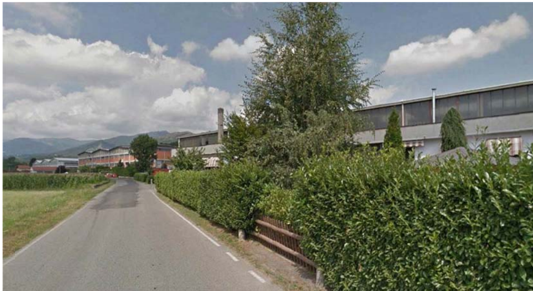
Figura 56: insediamenti commerciali e industriali lungo via Banna.
