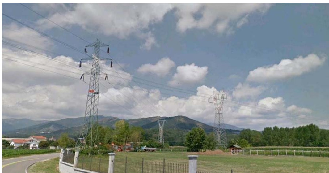
Figura 61: fitta rete di elettrodotti presente nell'area vasta
