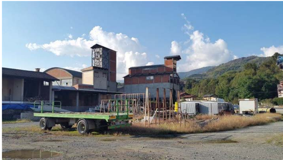
Figura 60: edifici industriali di dubbia qualità architettonica
