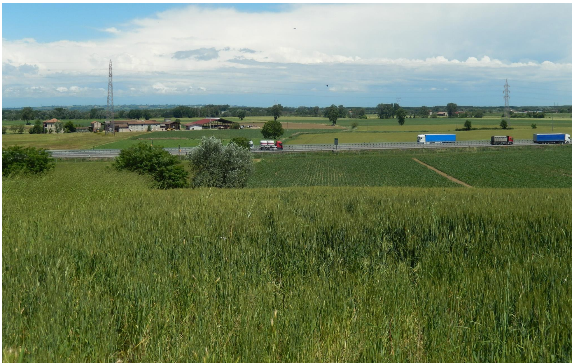
Foto 38a – Vista ravvicinata della campata tra i sostegni 15 e 14. A sinistra dall'autostrada A21 Torino – Piacenza SIMULAZIONE DI INSERIMENTO
