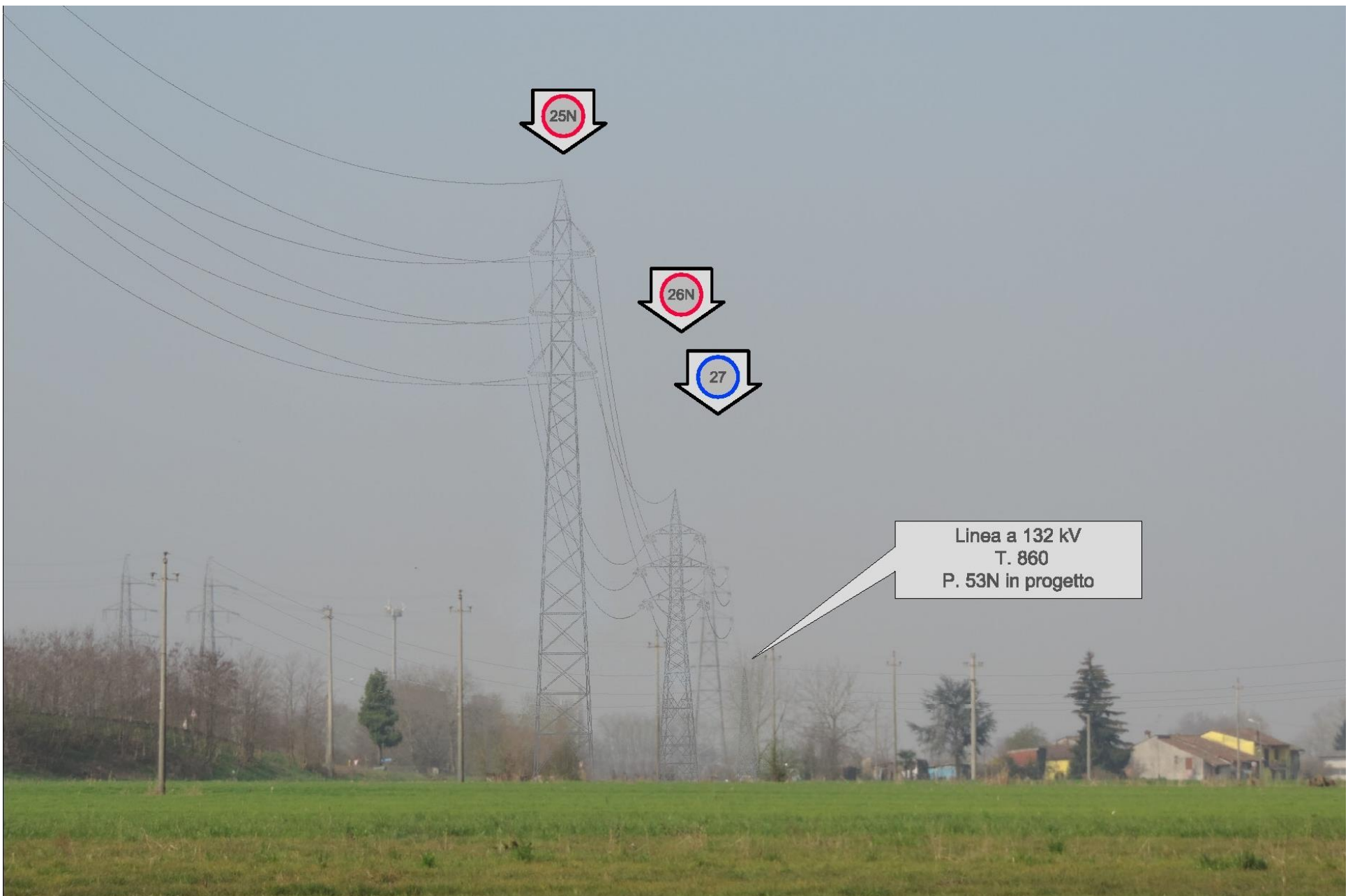
Foto 58 – Vista verso i sostegni 25, 26 e 27. SIMULAZIONE DI INSERIMENTO
