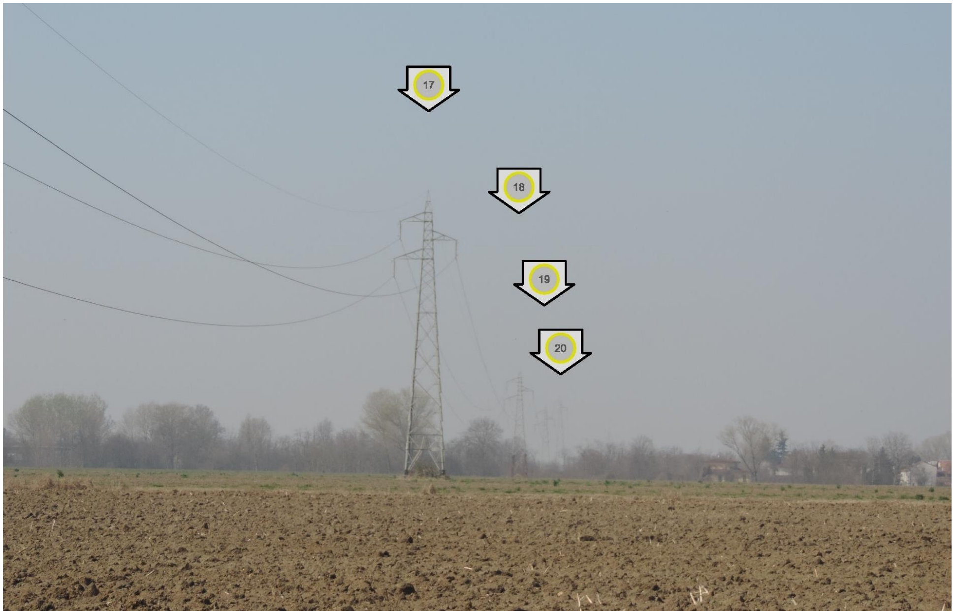
Foto 37 – Vista verso i sostegni 17, 18, 19 e 20. STATO ATTUALE
