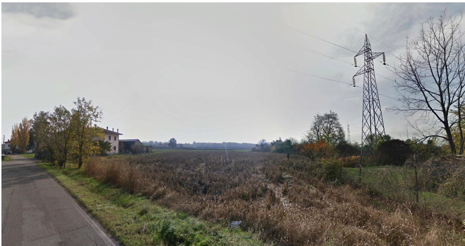
Foto 61 – Vista del sostegno 26 STATO ATTUALE
