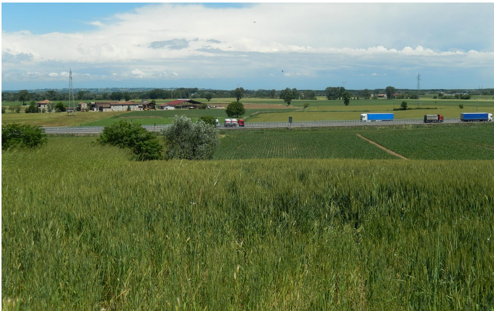
Foto 38a – Vista ravvicinata della campata tra i sostegni 15 e 14. A sinistra dall'autostrada A21 Torino – Piacenza STATO ATTUALE
