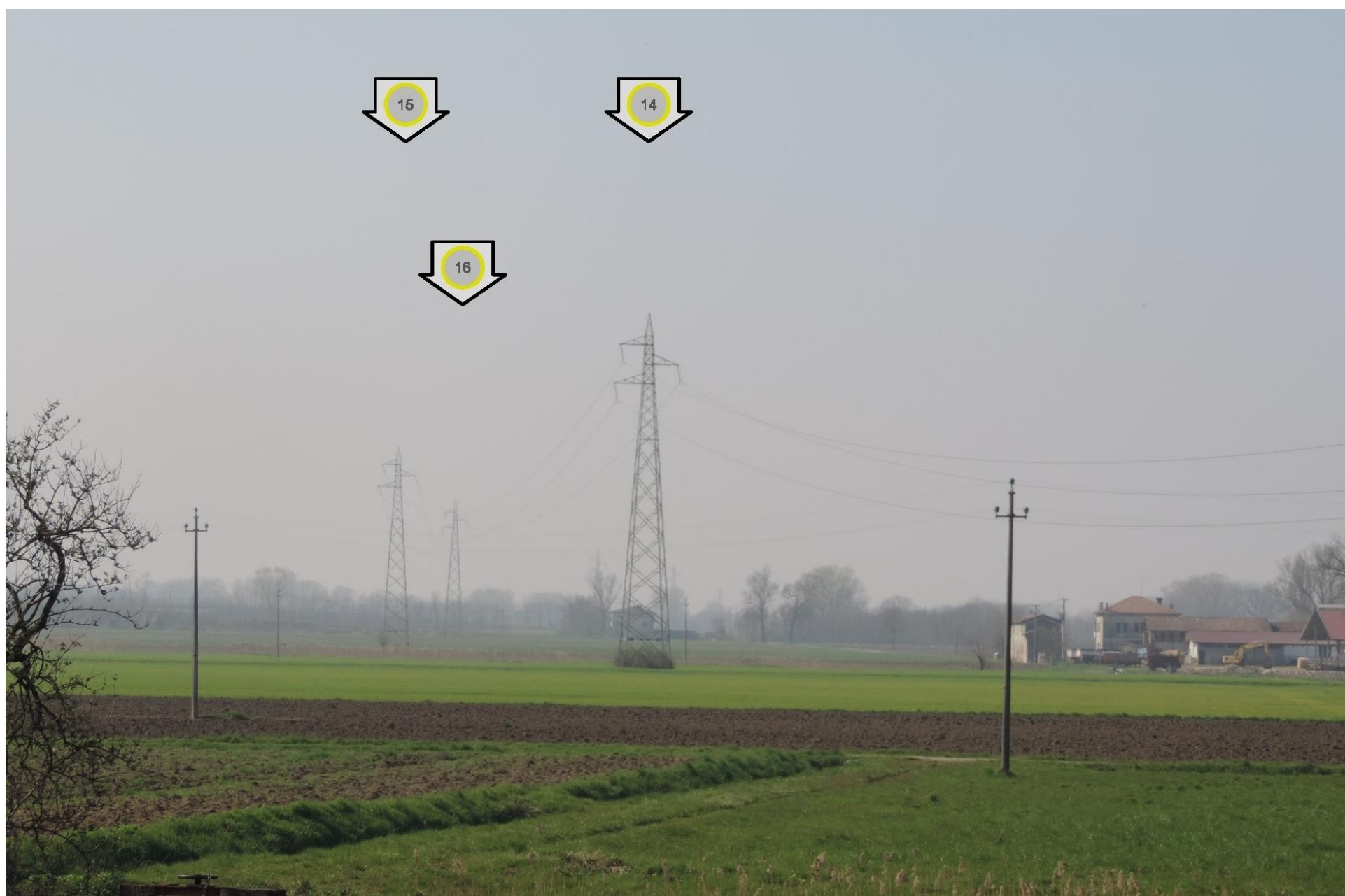
Foto 34 – Vista dei sostegni 14, 15 e 16. STATO ATTUALE
