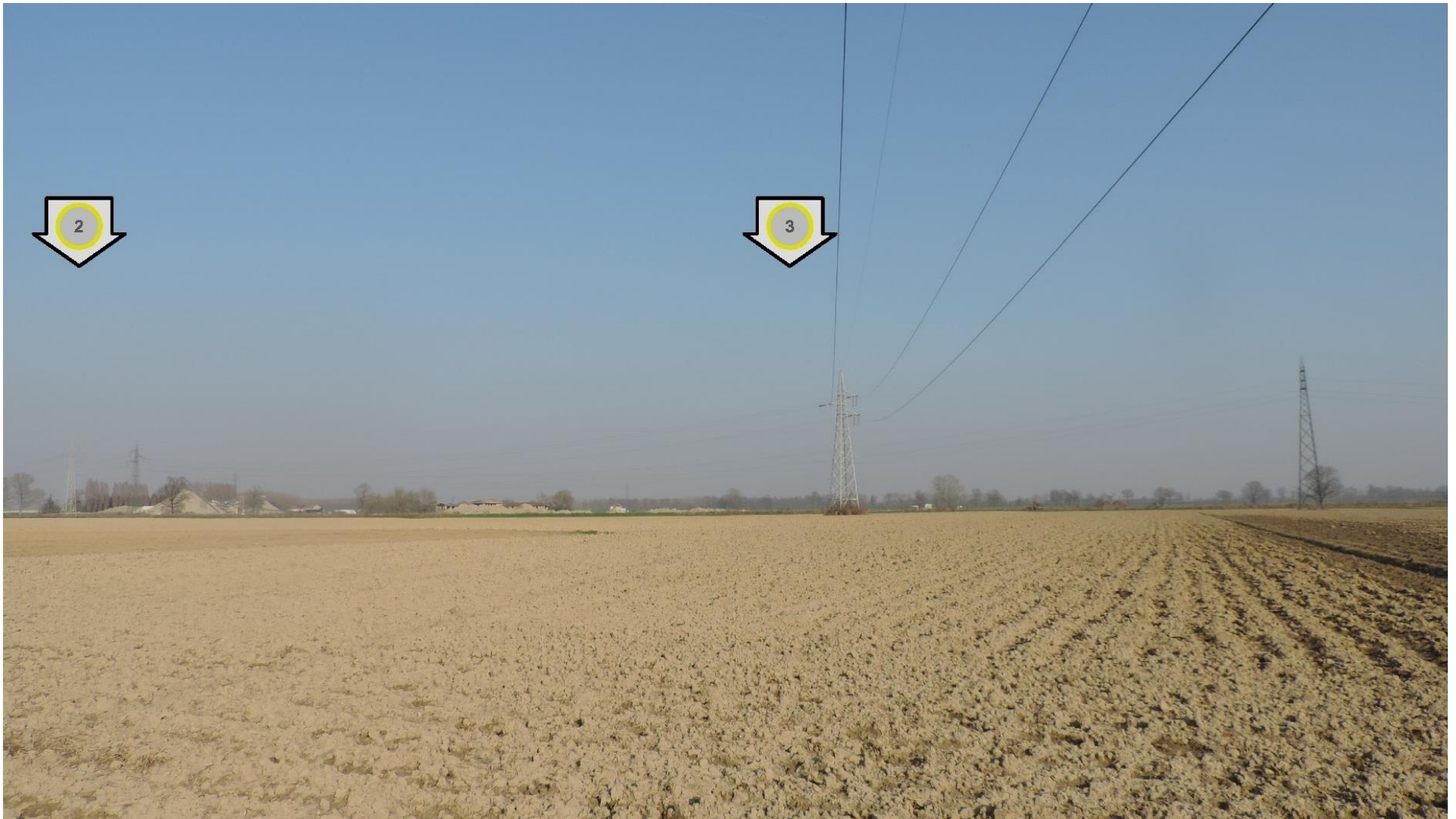
Foto 6 – Vista della campata tra i sostegni n. 2 e 3. STATO ATTUALE
