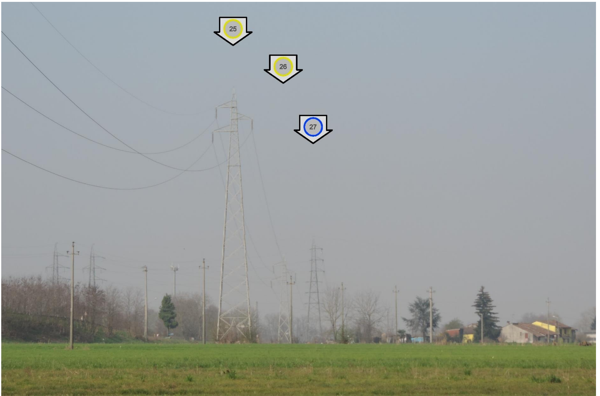
Foto 58 – Vista verso i sostegni 25, 26 e 27. STATO ATTUALE
