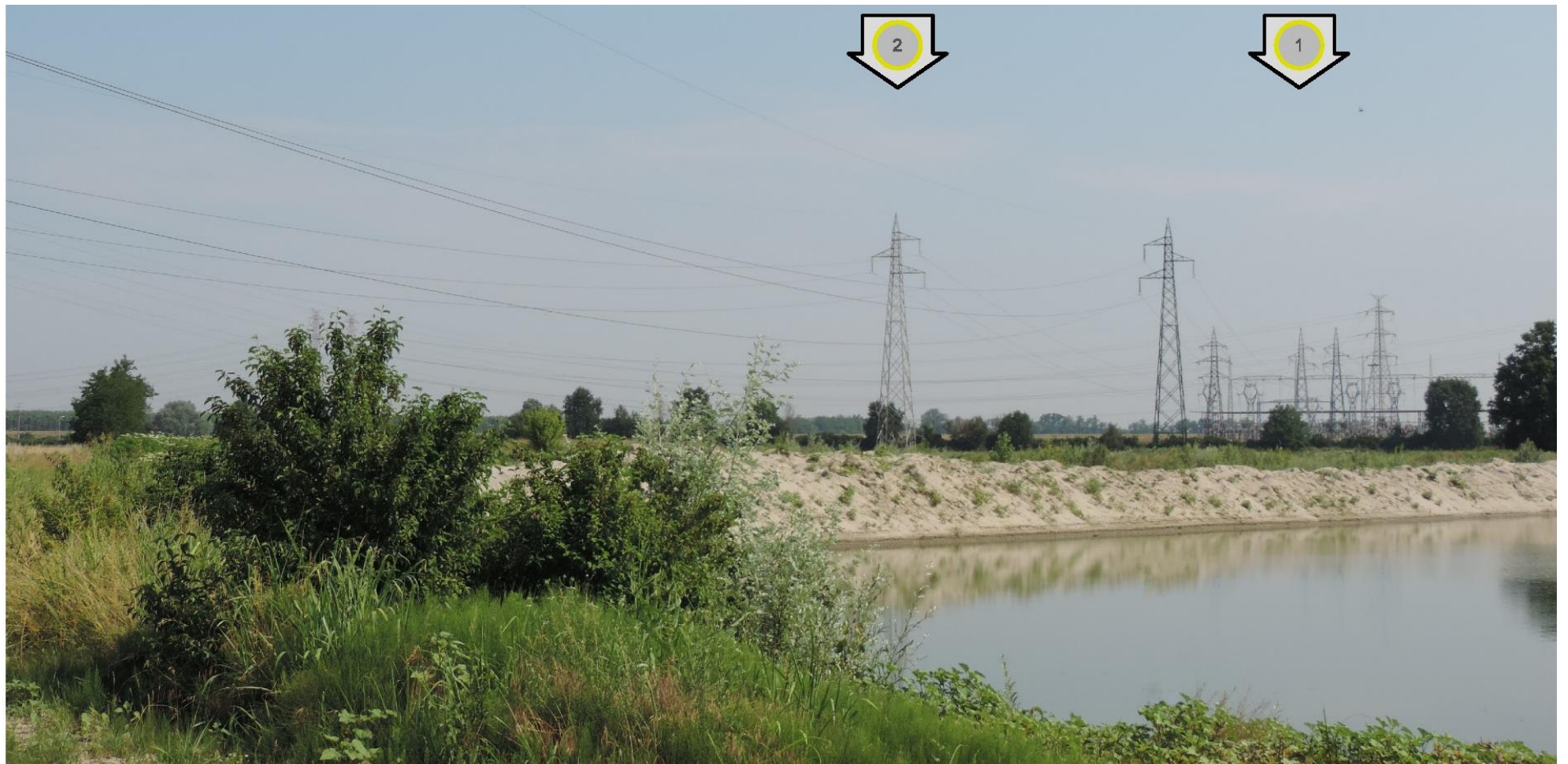
Foto 5 – Vista della campata tra i sostegni n. 1 e 2. In primo piano il lago di cava in località Cascina Ca' Nova. STATO ATTUALE
