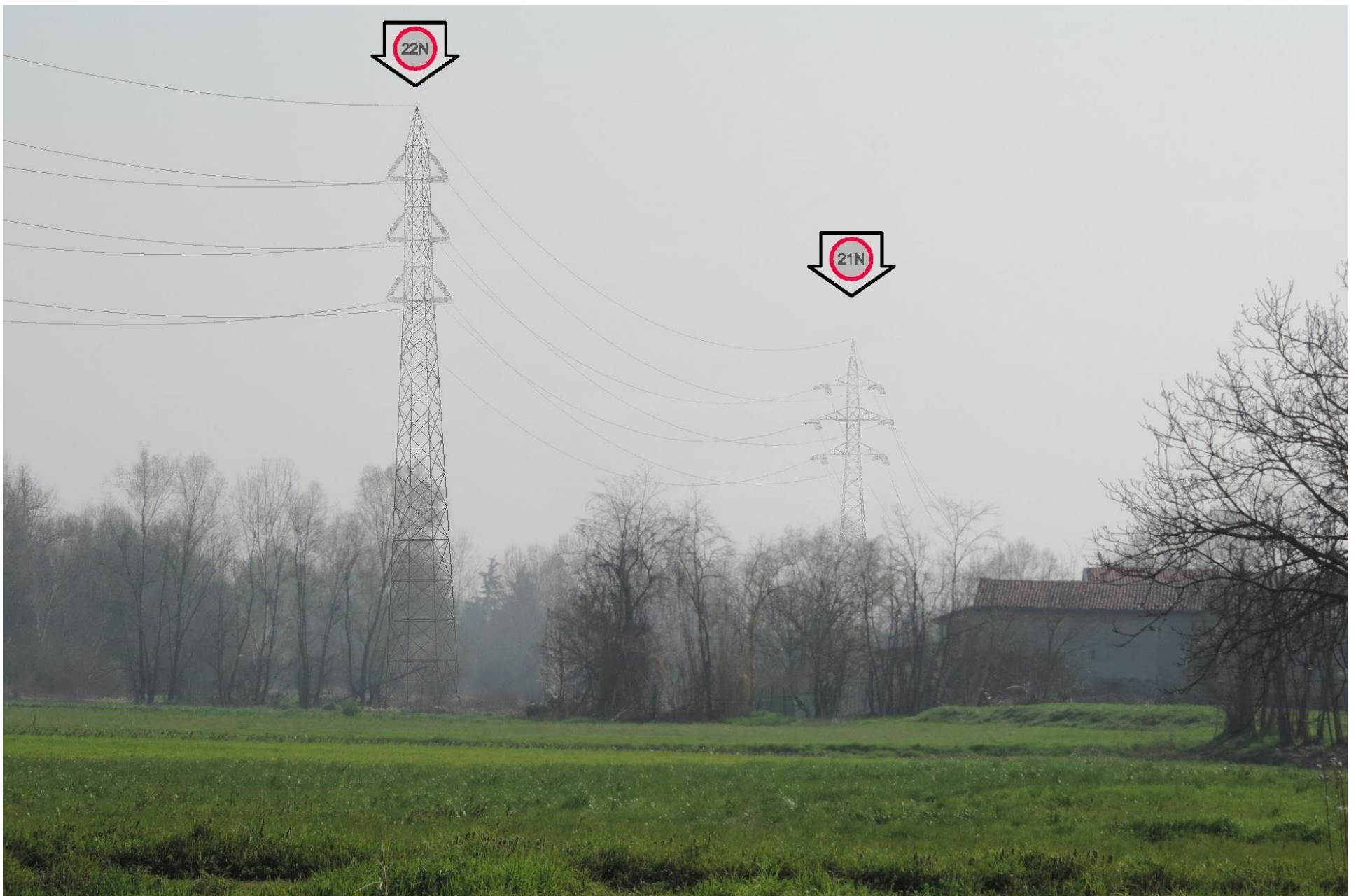
Foto 47 – Vista verso i sostegni 22 e 21. SIMULAZIONE DI INSERIMENTO
