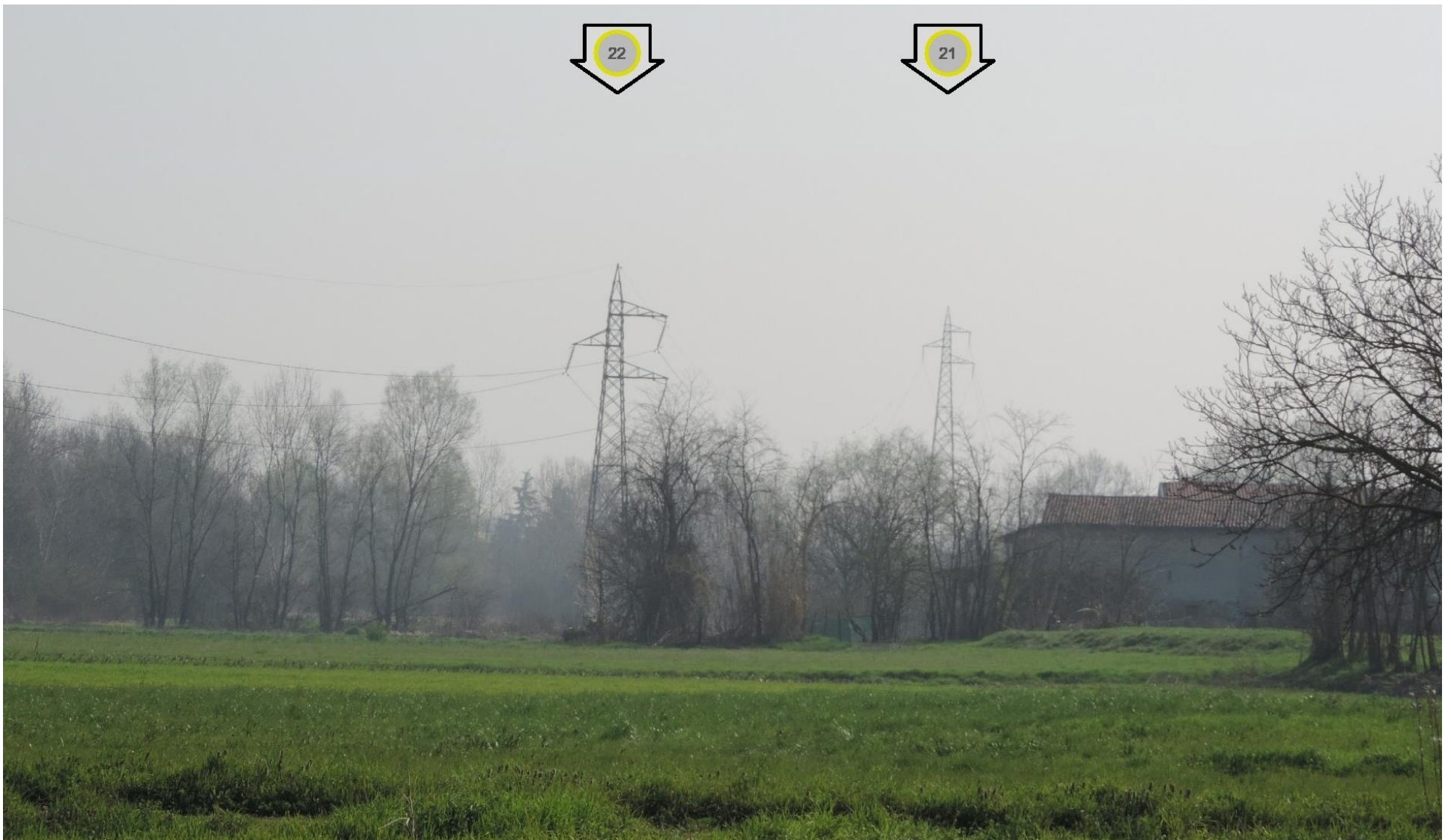
Foto 47 – Vista verso i sostegni 22 e 21. STATO ATTUALE
