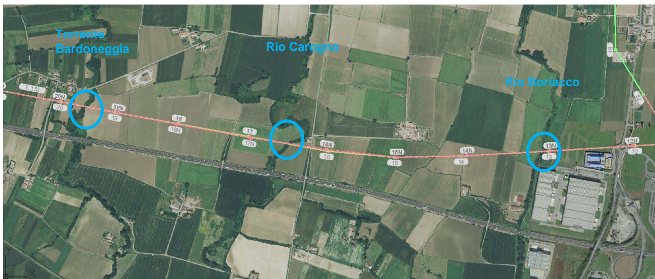
Figura 26: Attraversamento dei corsi d'acqua da parte della nuova linea T153
