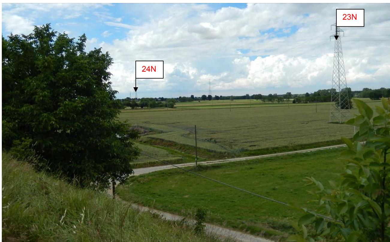
Figura 47: Vista della tratta tra i sostegni 23N-24N in località Colombarolo (Arena Po)
