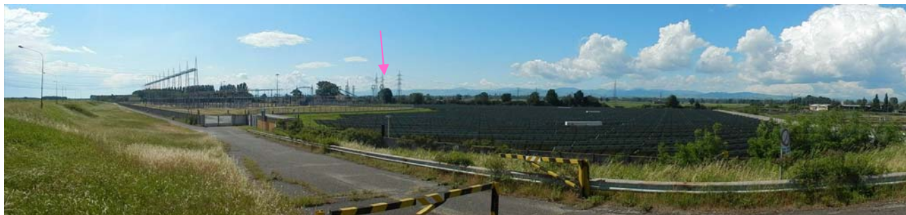
Figura 32: Ambito della Stazione Elettrica La Casella. In primo piano si nota l'impianto fotovoltaico; la freccia indica il sostegno che sarà demolito
