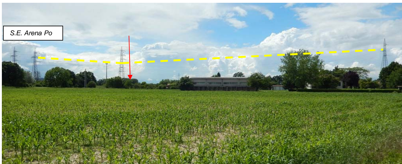
Figura 49: Vista dalla SP144 (località C.na Pradellina – Arena Po) del tratto di linea T. 860 “Arena Po – Copiano - Corteolona” interessato dagli interventi (la linea rossa indica la posizione del nuovo sostegno 53N; la linea gialla i conduttori che verranno eliminati)
