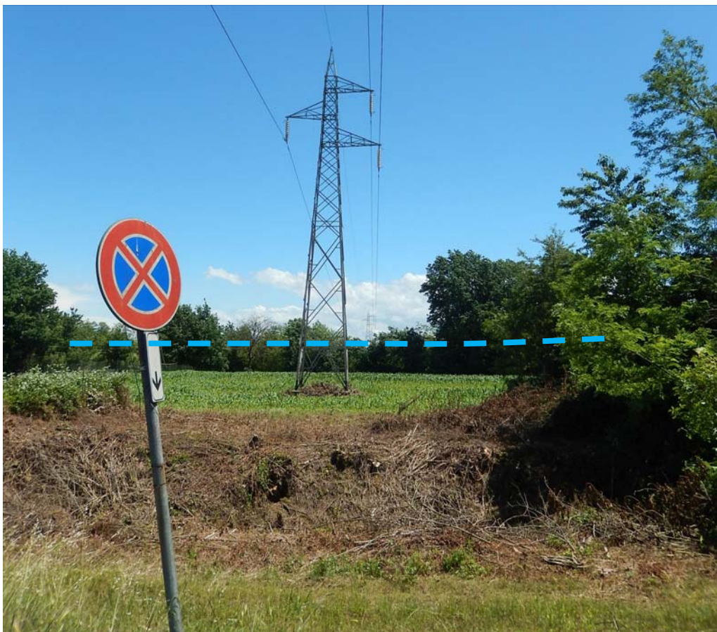
Figura 53: Vista verso est dalla località Zappellone (Arena Po) dell'attraversamento del Torrente Bardoneggia (individuato dalla linea azzurra) tra i sostegni 19N e 20N (in primo piano)
