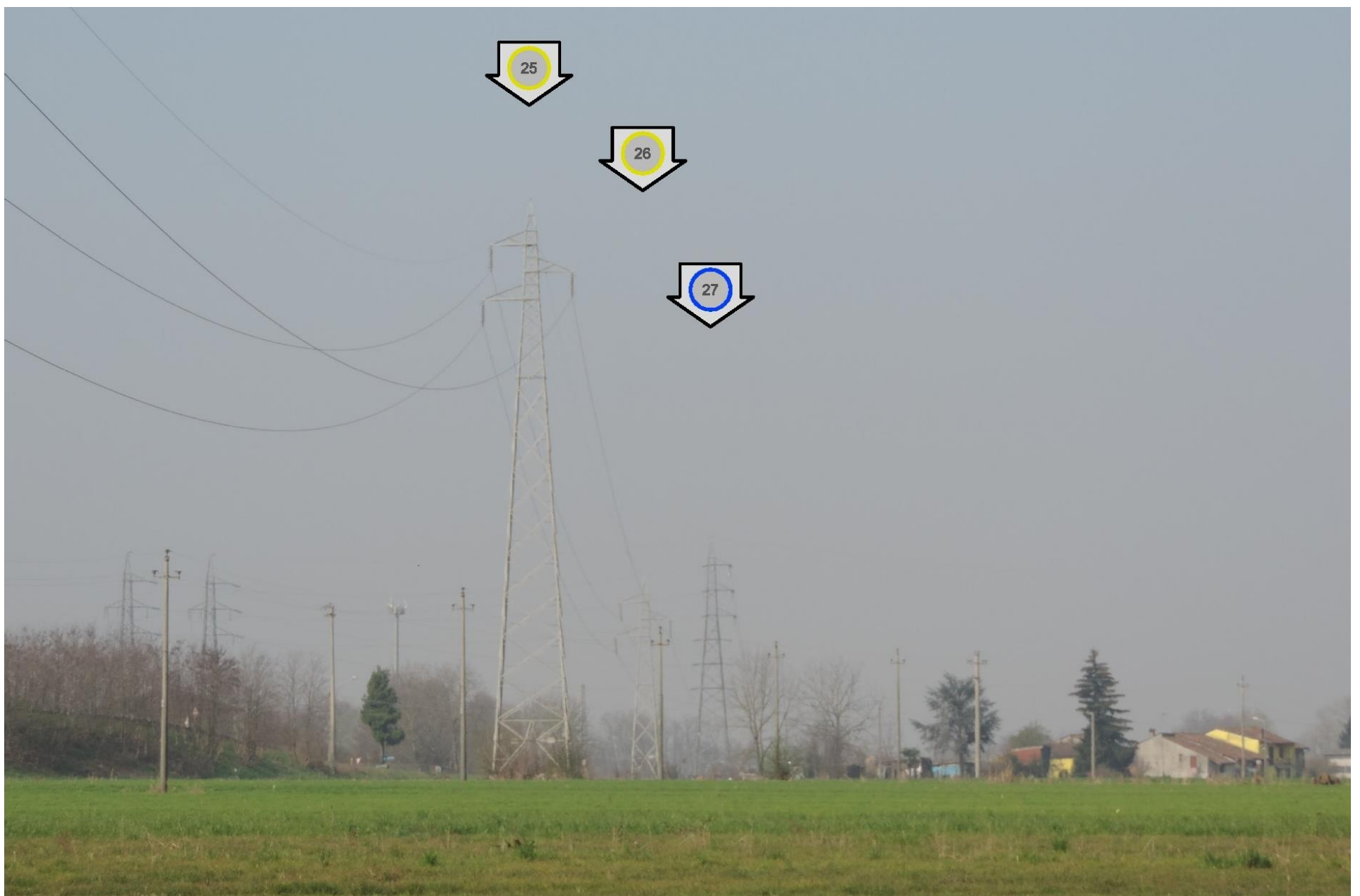
Foto 58 – Vista verso i sostegni 25, 26 e 27. STATO ATTUALE
