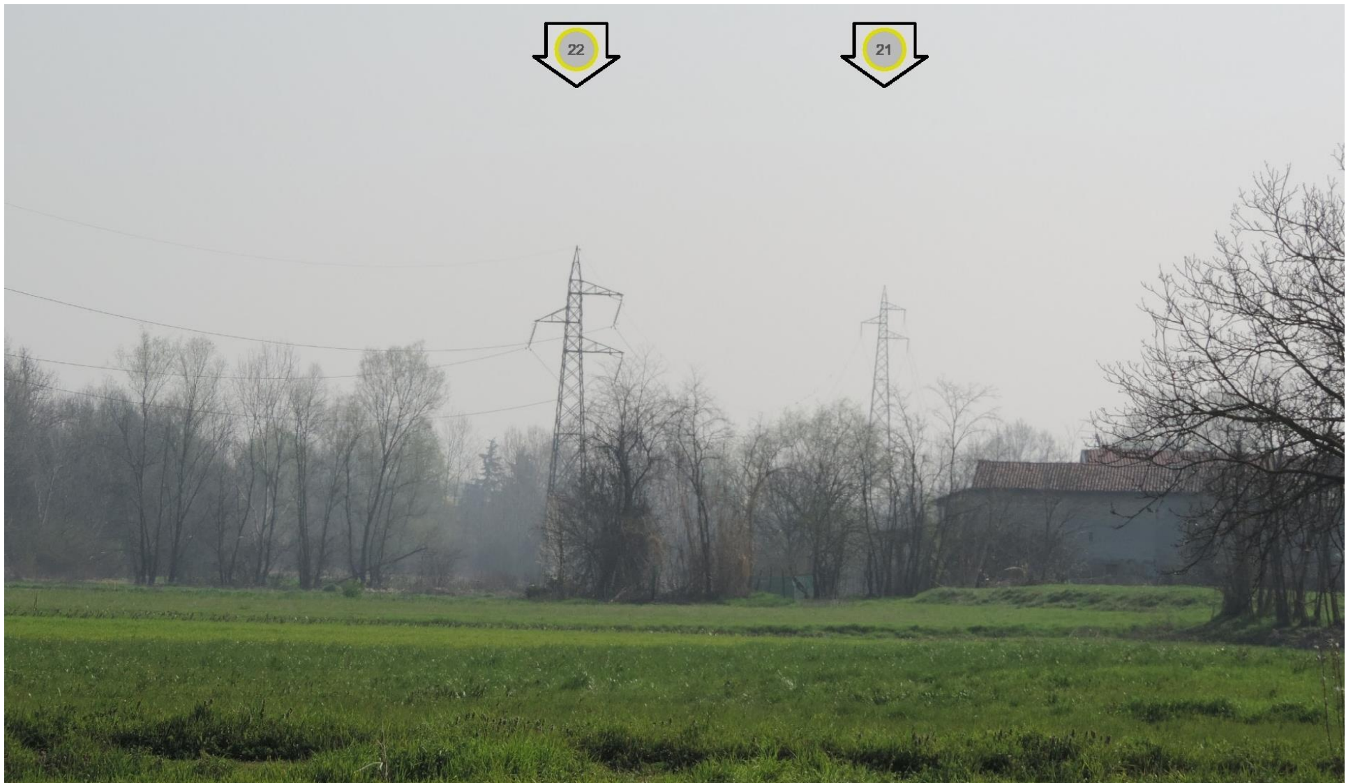
Foto 47 – Vista verso i sostegni 22 e 21. STATO ATTUALE
