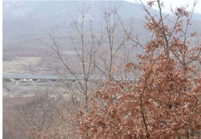
Foto 6 – Sullo sfondo nuovo viadotto Torretta.
