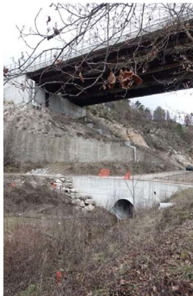
Foto 8 – Aspetto del corso d'acqua al di sotto del Viadotto Pennarone I.
