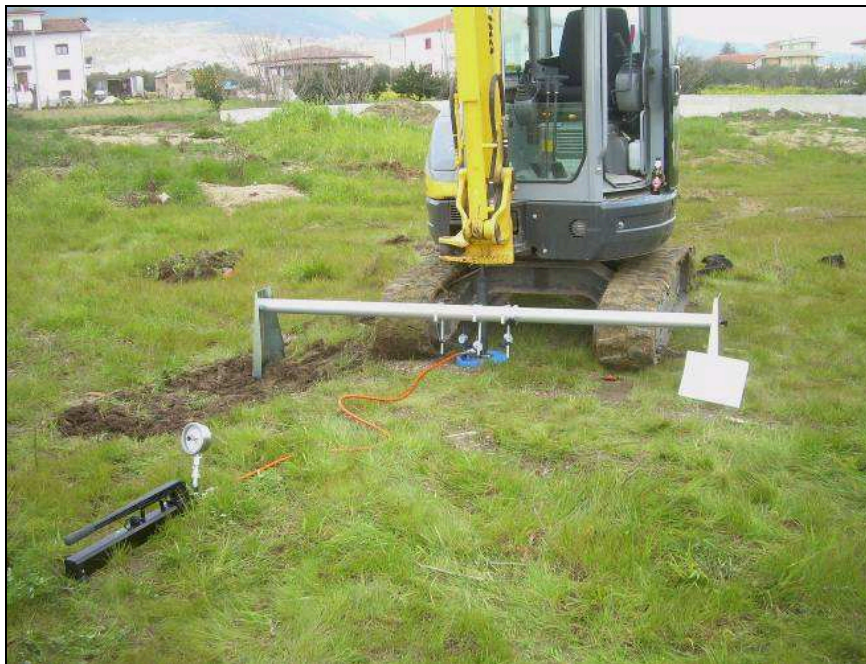
PROVA DI CARICO SU PIASTRA n°2
