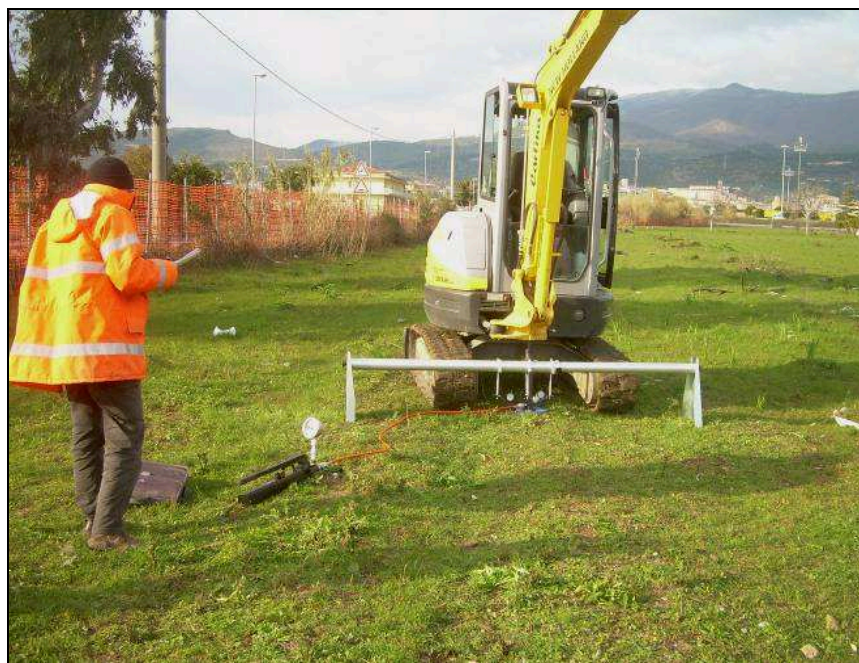
PROVA DI CARICO SU PIASTRA n°4
