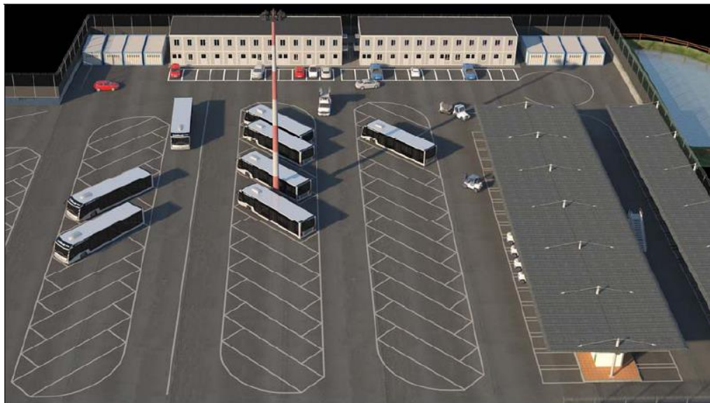
Figura 3-2 Vista nuova area handler
