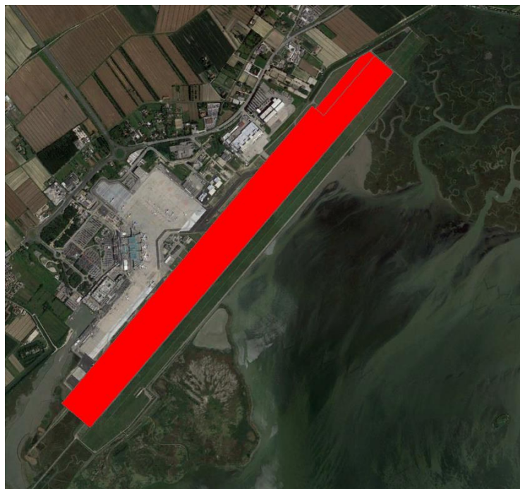
Figura 4-7 Localizzazione cantiere operativo Ampliamento infrastruttura di volo
