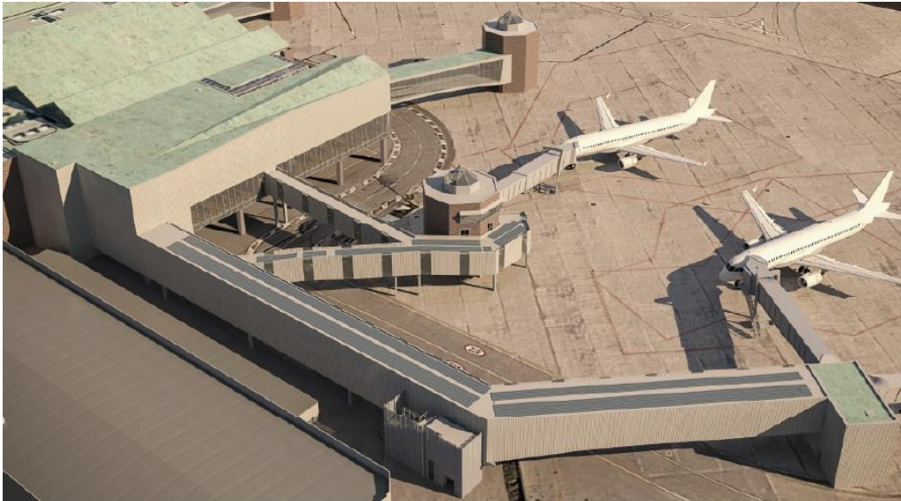
Figura 4-1 Vista ampliamento terminal Pier Sud
