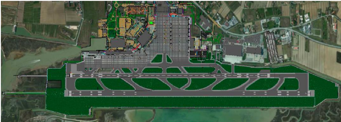
Figura 4-6 Vista aerea ampliamento infrastruttura di volo
