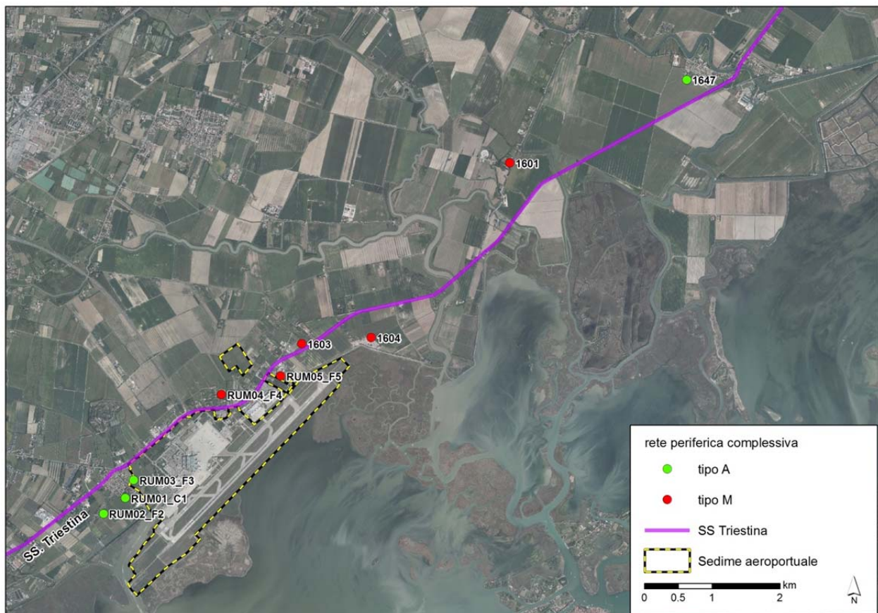
Figura 3-18 Rete periferica complessiva del sistema di monitoraggio 2016-2021 – In verde le centraline di tipo A, in rosso quelle di tipo M.
