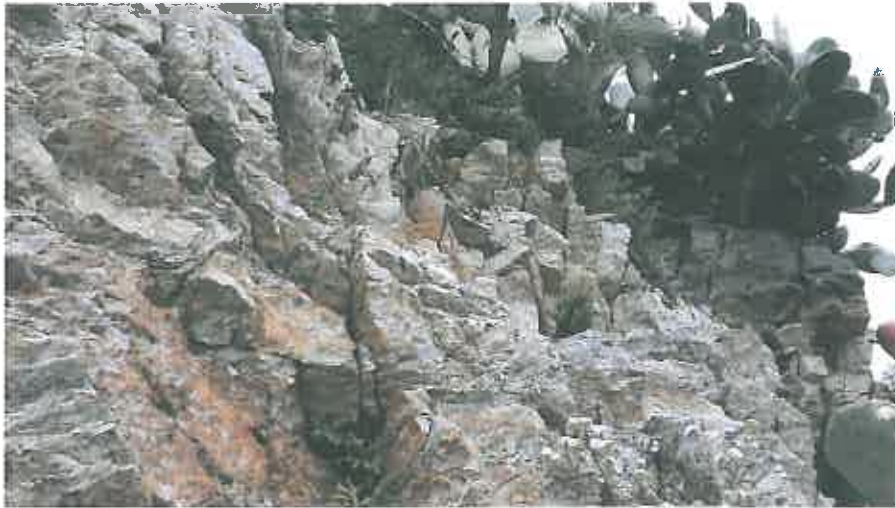
Fig.9 Affioramento in prossimità del blocco di ancoraggio A1.
