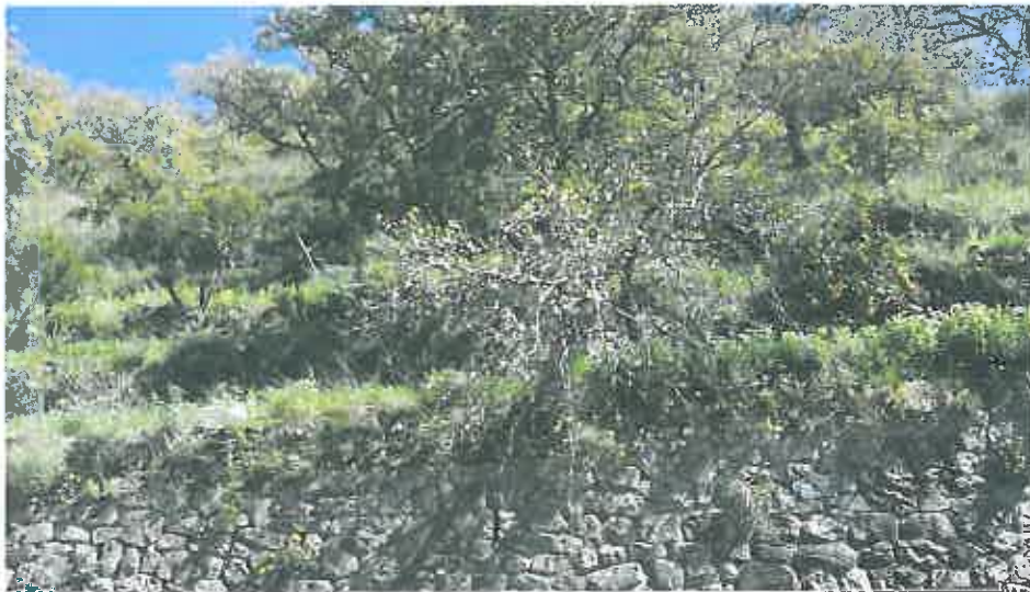
Fig.10 Coperture terrazzate a monte della SP per Cardeto.
