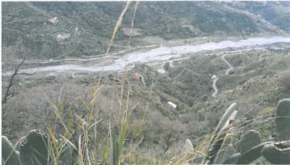
Fig.19 Vista da monte verso valle del tratto in prossimità del blocco di ancoraggio A1
