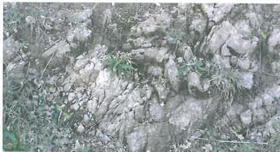
Fig.8 Affioramento di Scisti biotitici estremamente fratturati ed alterati nel tratto più a monte della condotta
