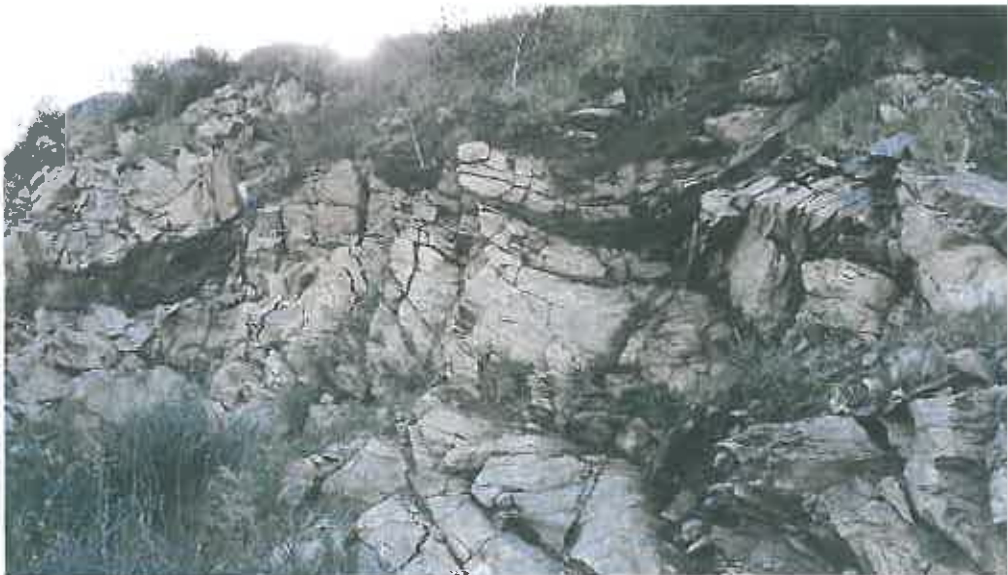
Fig.5 Affioramento di Scisti biotitici immediatamente a monte della Vasca di carico n° 2. Si noti l'intensa piegatura e la presenza di un banco bruno profondamente alterato.
