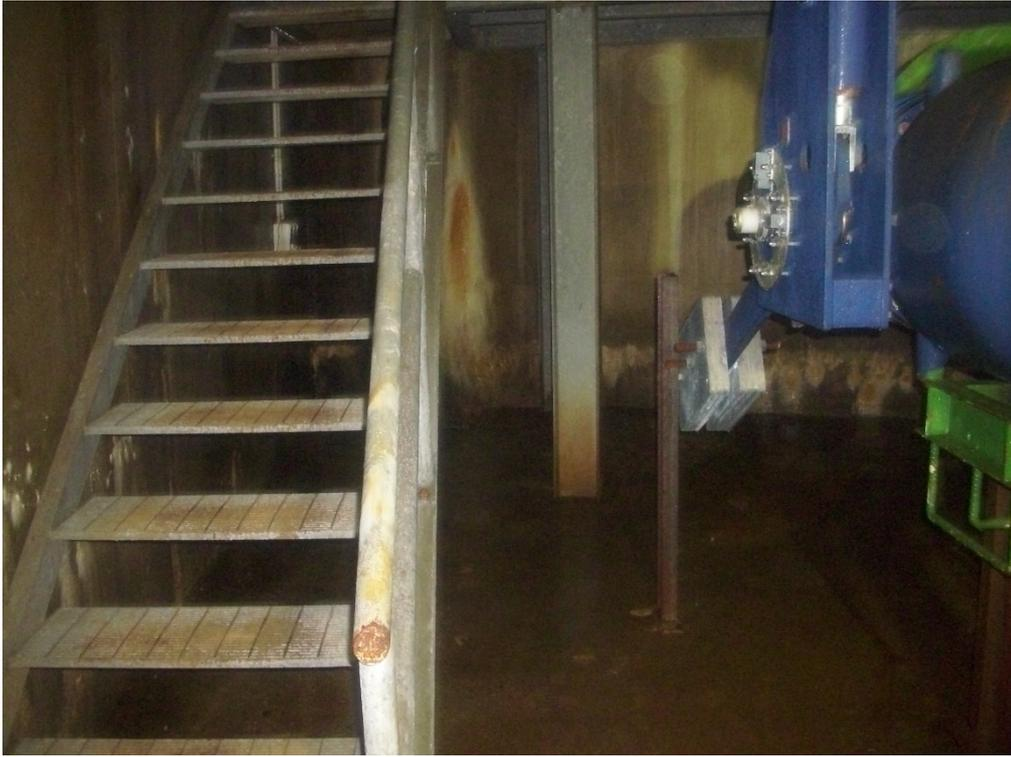
Camera valvole dell'opera di presa dall'invaso: valvola a contrappeso su by-pass DN500
