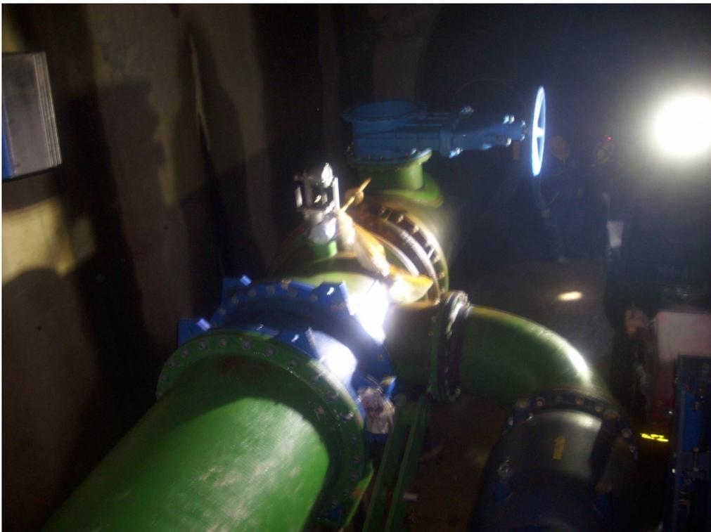
Camera valvole dell'opera di presa dall'invaso: condotta forzata DN900 e by-pass DN500
