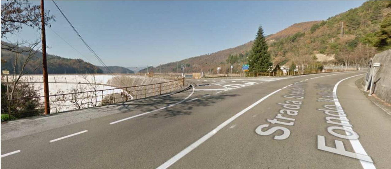
Figura 3.p - Vista della diga sul Fiume Agri
