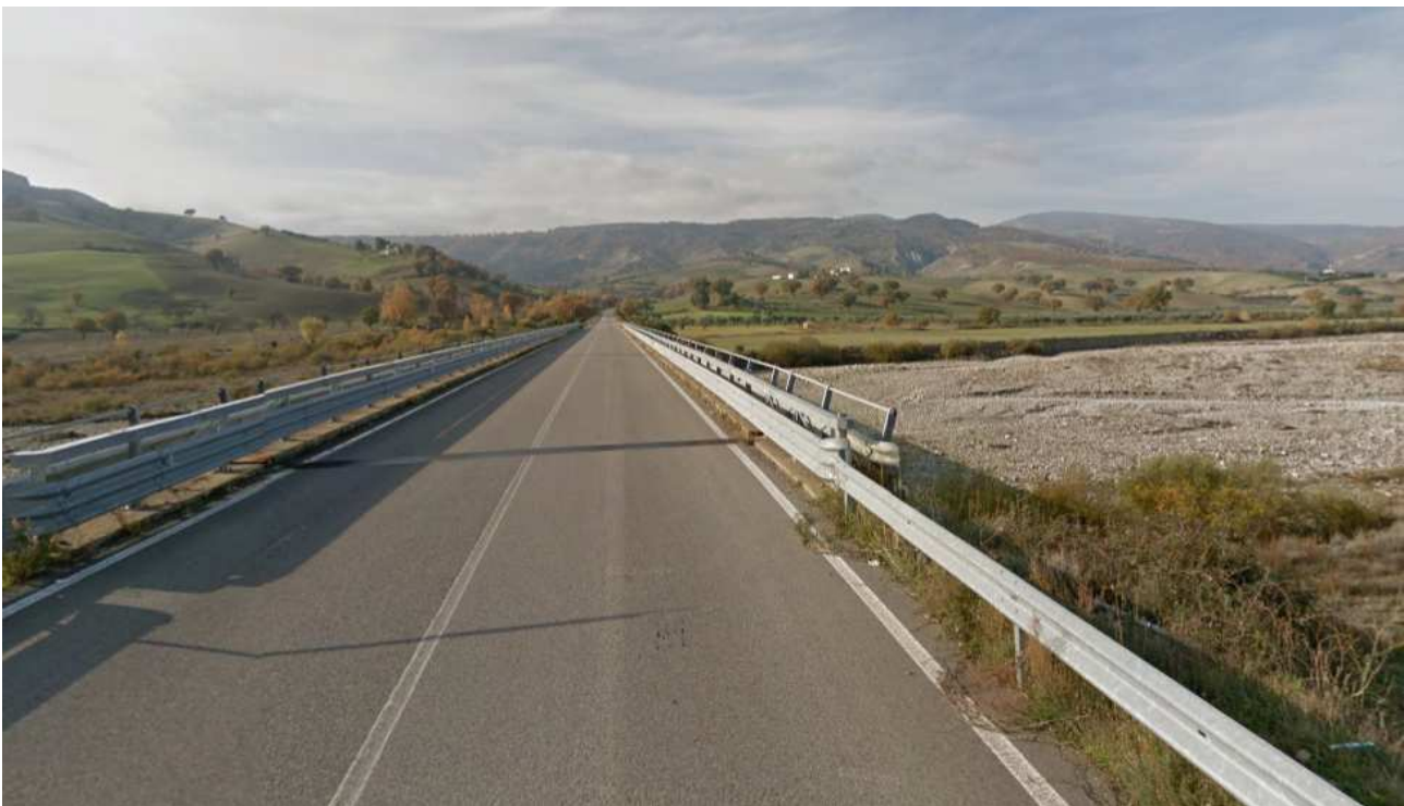
Figura 3.n - Attraversamento sul Torrente Cerreto
