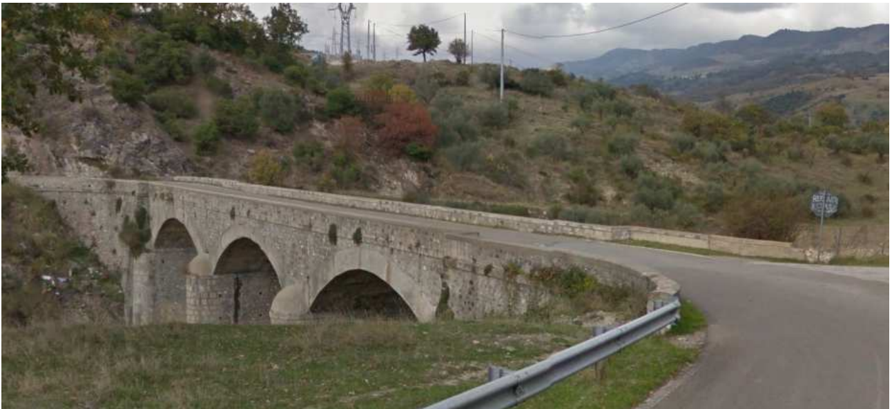
Figura 3.m - Ponte sulla Fiumarella di Corleto.
