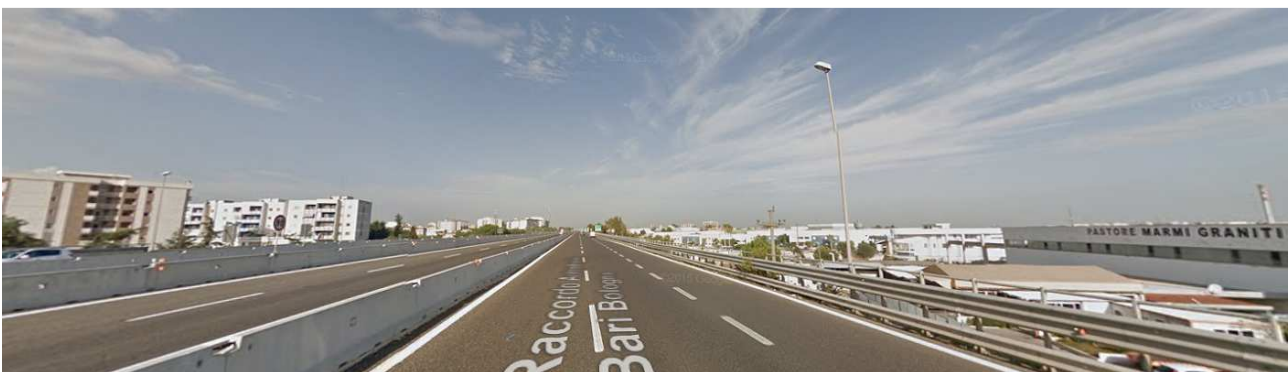
Figura 3.s - Attraversamento di Modugno (BA)
