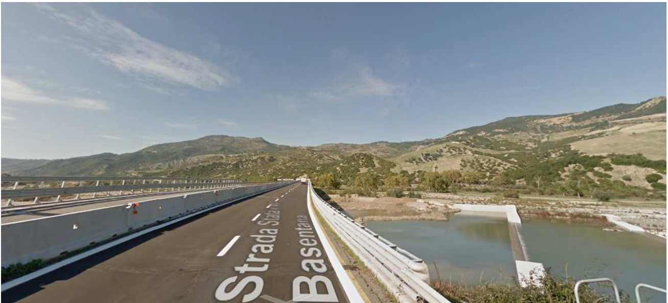
Figura 3.t: Viadotto sul Basento al km 42 della SS 407.
