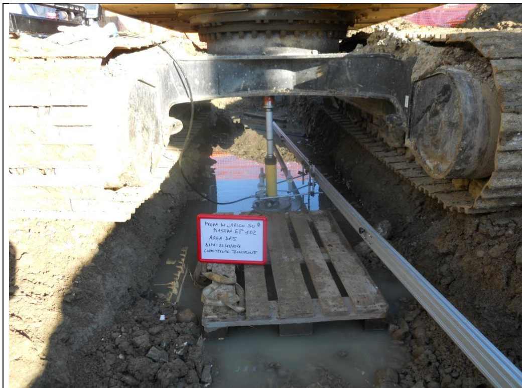
Prova di carico su piastra EP 102
