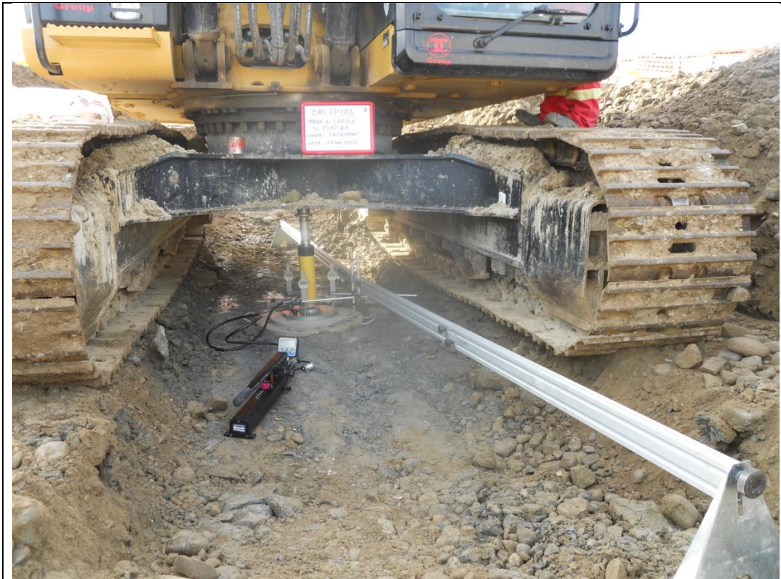
Prova di carico su piastra EP 103
