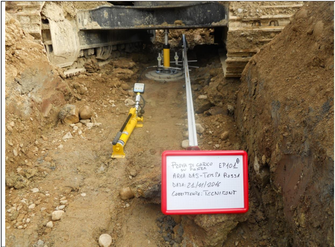
Prova di carico su piastra EP 101
