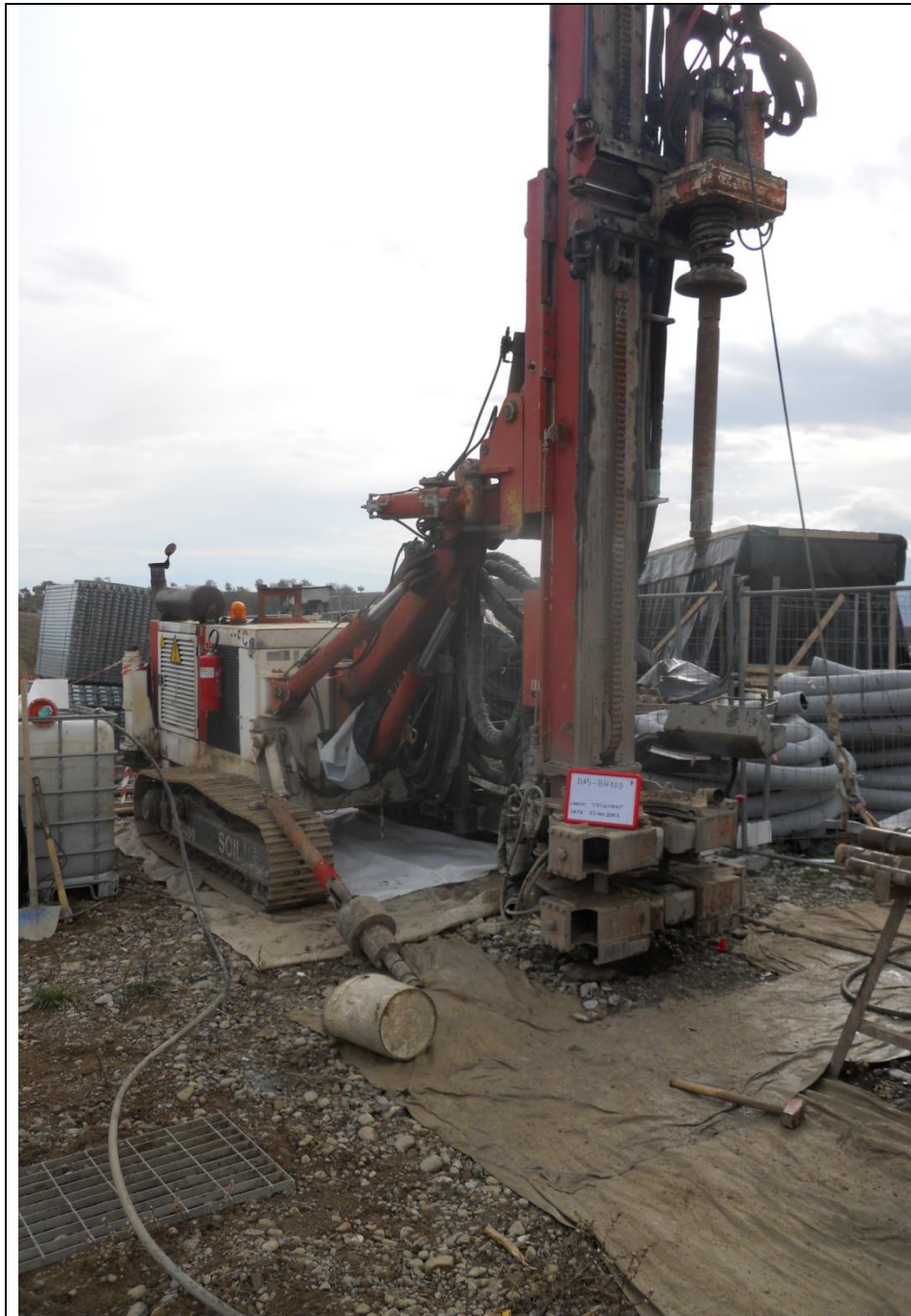
SONDAGGIO BH 103PZ: postazione
