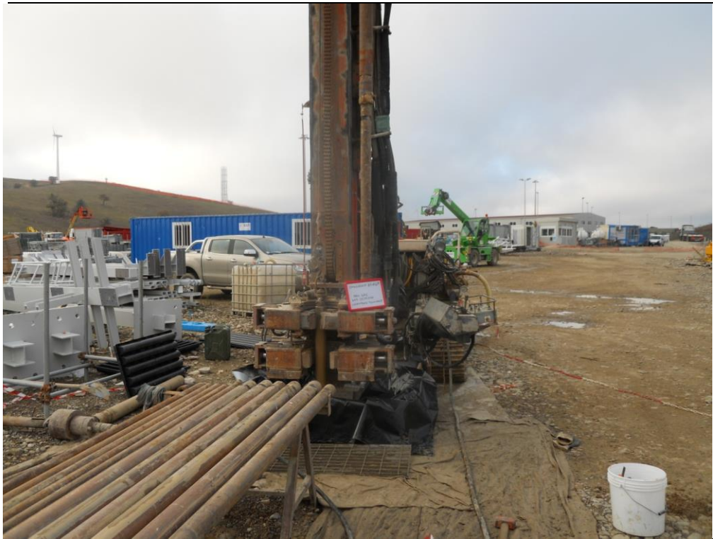
SONDAGGIO BH104PZ: postazione
