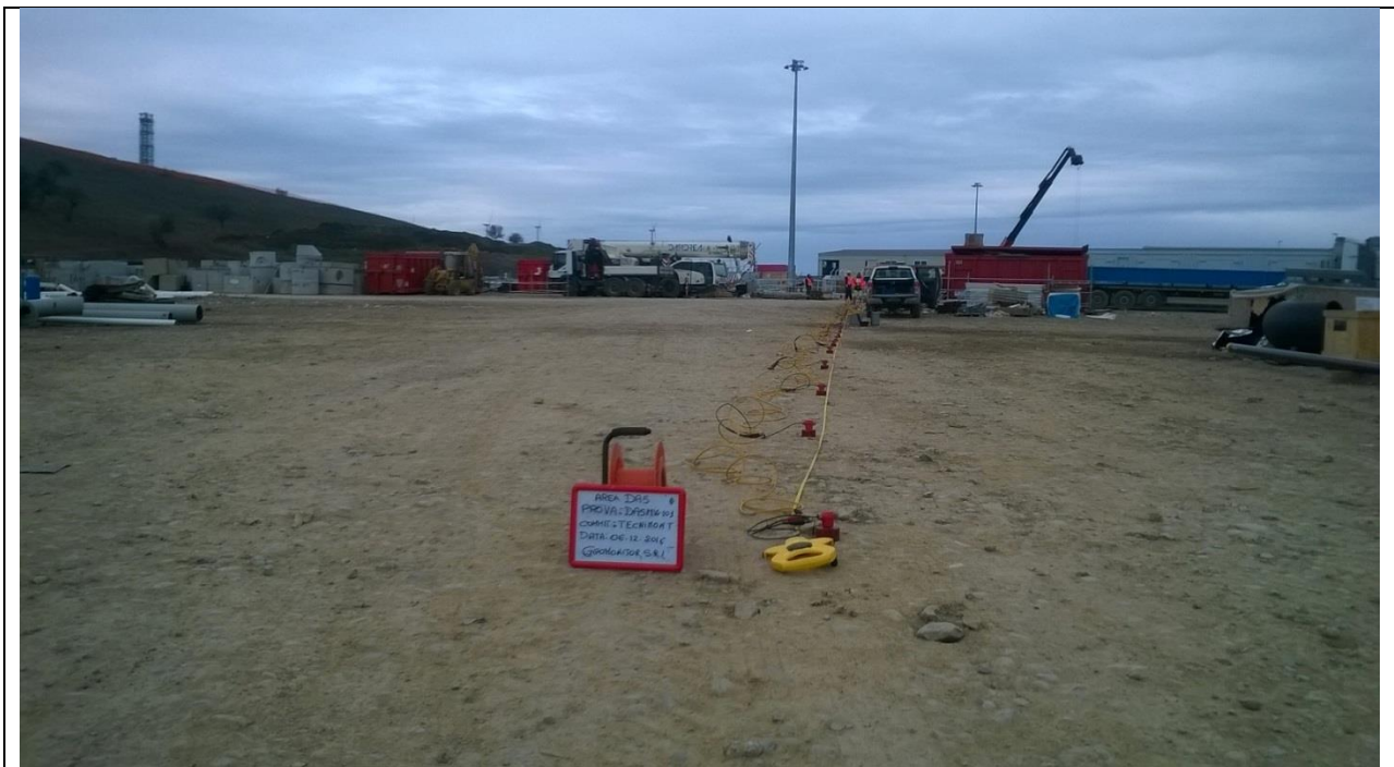
PROSPEZIONE SIMICA MASW MW101
