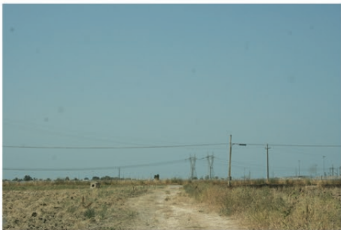
Cavidotto_WTG_9_10_sottostazione BR_sud (22).JPG
