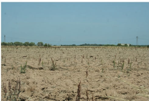
Cavidotto_WTG_9_10_sottostazione BR_sud (20).JPG
