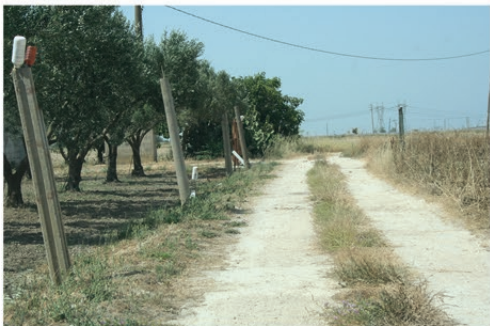
Cavidotto_WTG_9_10_sottostazione BR_sud (11).JPG
