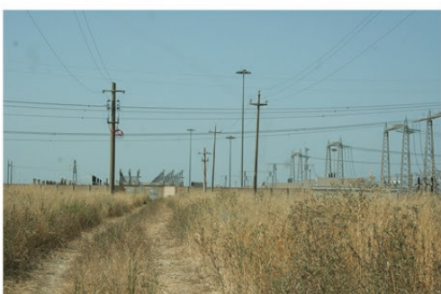
Cavidotto_WTG_9_10_sottostazione BR_sud (40).JPG
