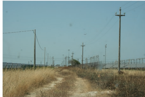
Cavidotto_WTG_9_10_sottostazione BR_sud (34).JPG
