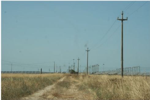
Cavidotto_WTG_9_10_sottostazione BR_sud (33).JPG
