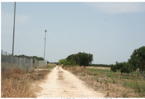
Cavidotto WTG_4_3 (1).JPG
