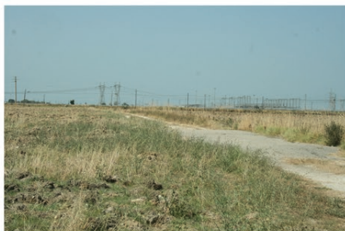
Cavidotto_WTG_9_10_sottostazione BR_sud (16).JPG
