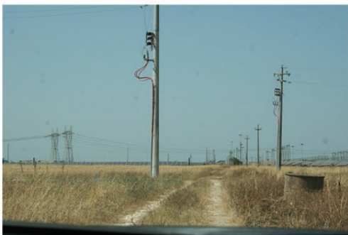
Cavidotto_WTG_9_10_sottostazione BR_sud (31).JPG
