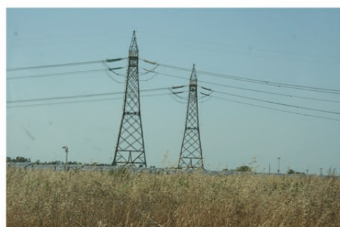
Cavidotto_WTG_9_10_sottostazione BR_sud (41).JPG
