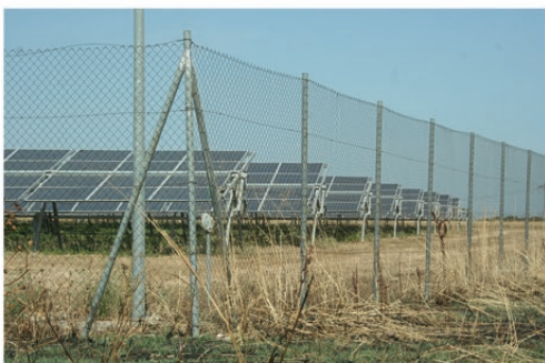
Cavidotto_WTG_9_10_sottostazione BR_sud (37).JPG
