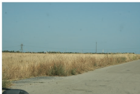
Cavidotto_WTG_9_10_sottostazione BR_sud (27).JPG
