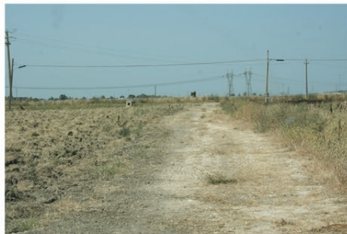
Cavidotto_WTG_9_10_sottostazione BR_sud (23).JPG
