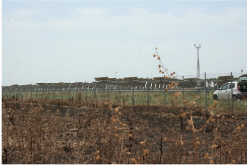
Cavidotto WTG_4_3 (2).JPG
