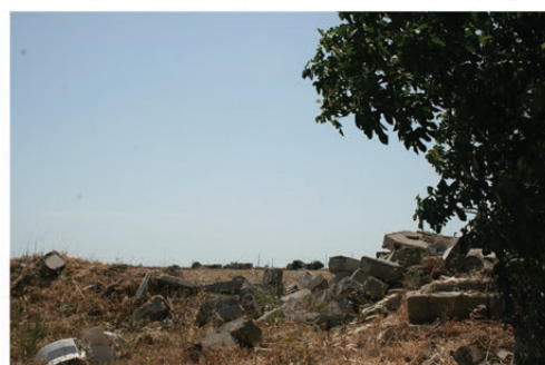
Cavidotto_WTG_9_10_sottostazione BR_sud (4).JPG
