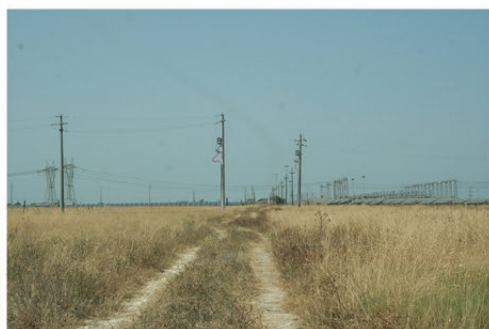
Cavidotto_WTG_9_10_sottostazione BR_sud (30).JPG
