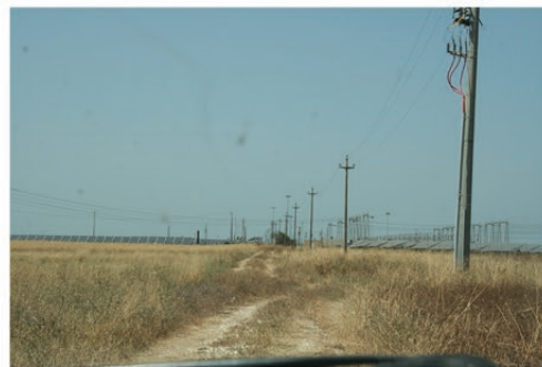
Cavidotto_WTG_9_10_sottostazione BR_sud (32).JPG
