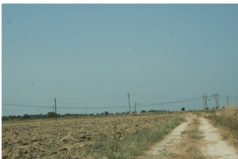
Cavidotto_WTG_9_10_sottostazione BR_sud (17).JPG
