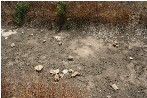
Cavidotto WTG_4_3 (6).JPG
