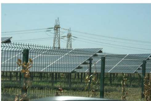
Cavidotto_WTG_9_10_sottostazione BR_sud (39).JPG
