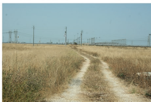
Cavidotto_WTG_9_10_sottostazione BR_sud (29).JPG
