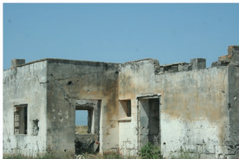
Cavidotto_WTG_9_10_sottostazione BR_sud (14).JPG
