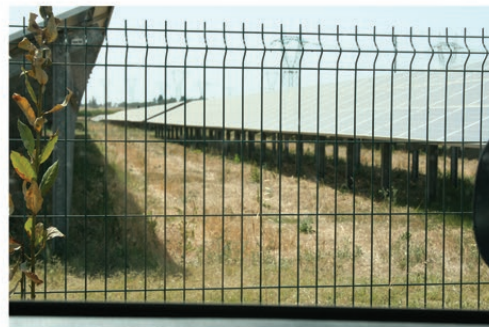
Cavidotto_WTG_9_10_sottostazione BR_sud (36).JPG
