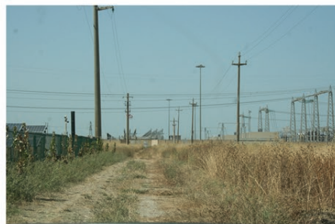
Cavidotto_WTG_9_10_sottostazione BR_sud (38).JPG
