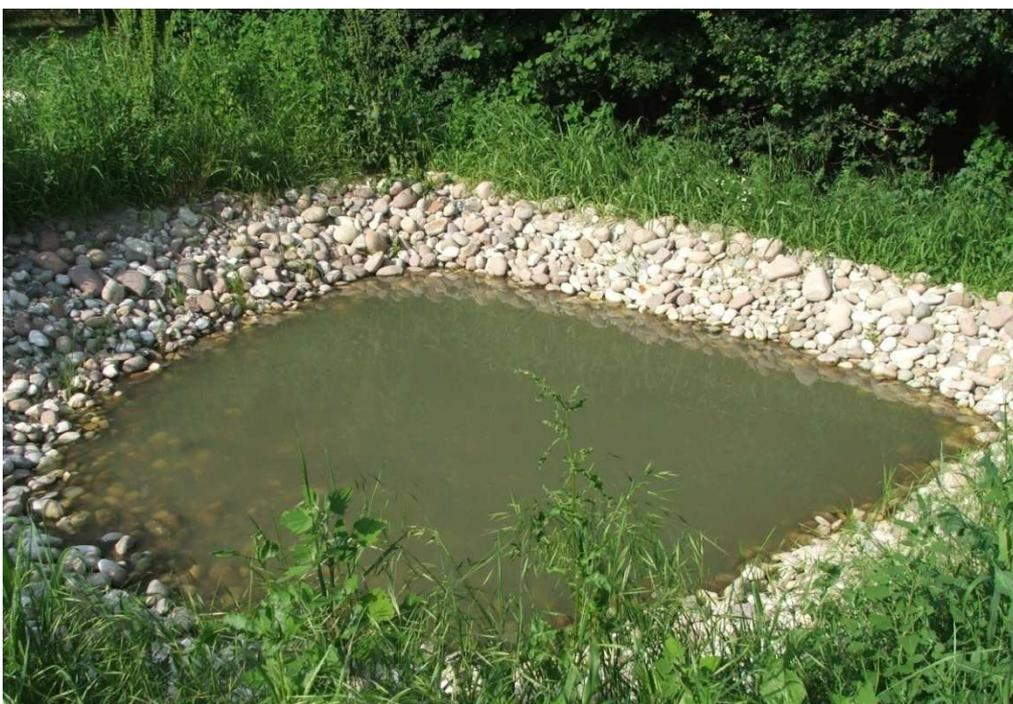
Fig. 3.4. – Stagno per Anfibi realizzato con impermeabilizzazione in telo di PVC e ricoperto di ciottoli.
