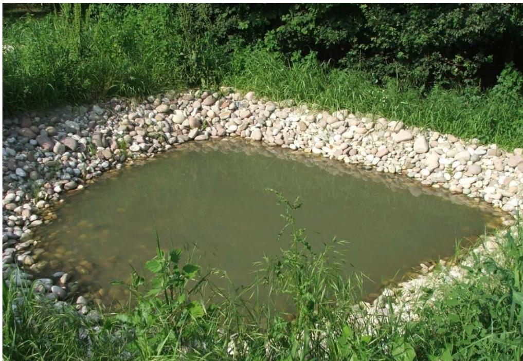
Fig. 3.12. – Stagno per Anfibi realizzato con impermeabilizzazione in telo di PVC e ricoperto di ciottoli.
