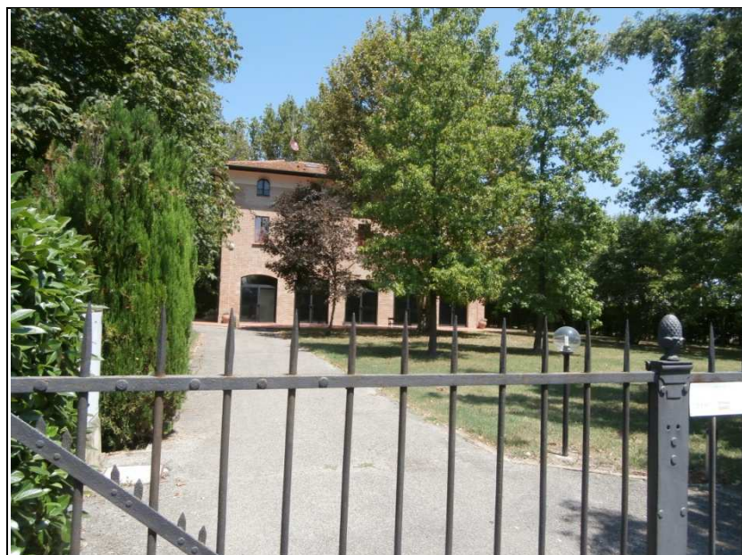
Figura 1.7. Edificio secondario "A"
