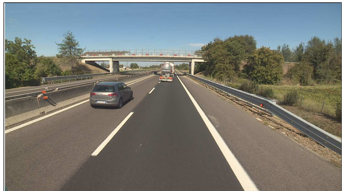
Figura 1.2. Stato ante operam del cavalcavia al km 4+500 dell'A13
