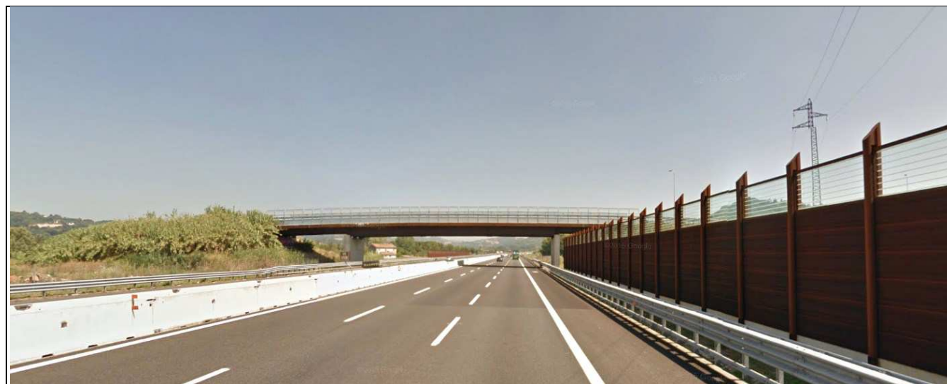
Figura 1.3. Cavalcavia e barriere in corten realizzate sull'A14.
