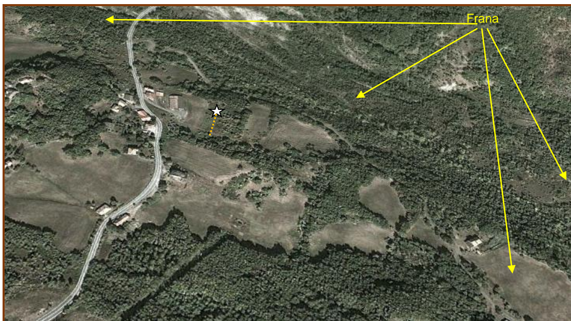
Fig. 7 – Vista d’insieme della morfologia e del paesaggio con ubicazione della proposta di perforazione C (stella bianca). La linea puntinata arancione individua indicativamente il tracciato della tubazione che si renderebbe necessario realizzare per l’allacciamento del pozzo qualora risultasse produttivo.
