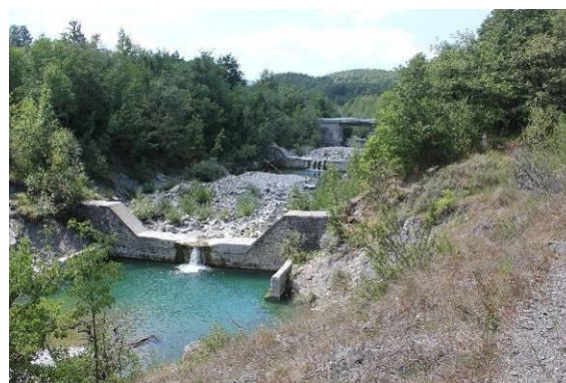
Dal ponte alla briglia 3
