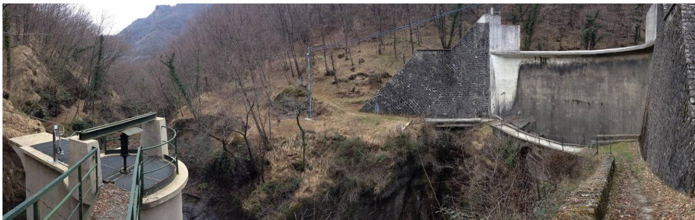
Nella foto: paramento di valle diga Zolezzi visto da sx orografica
