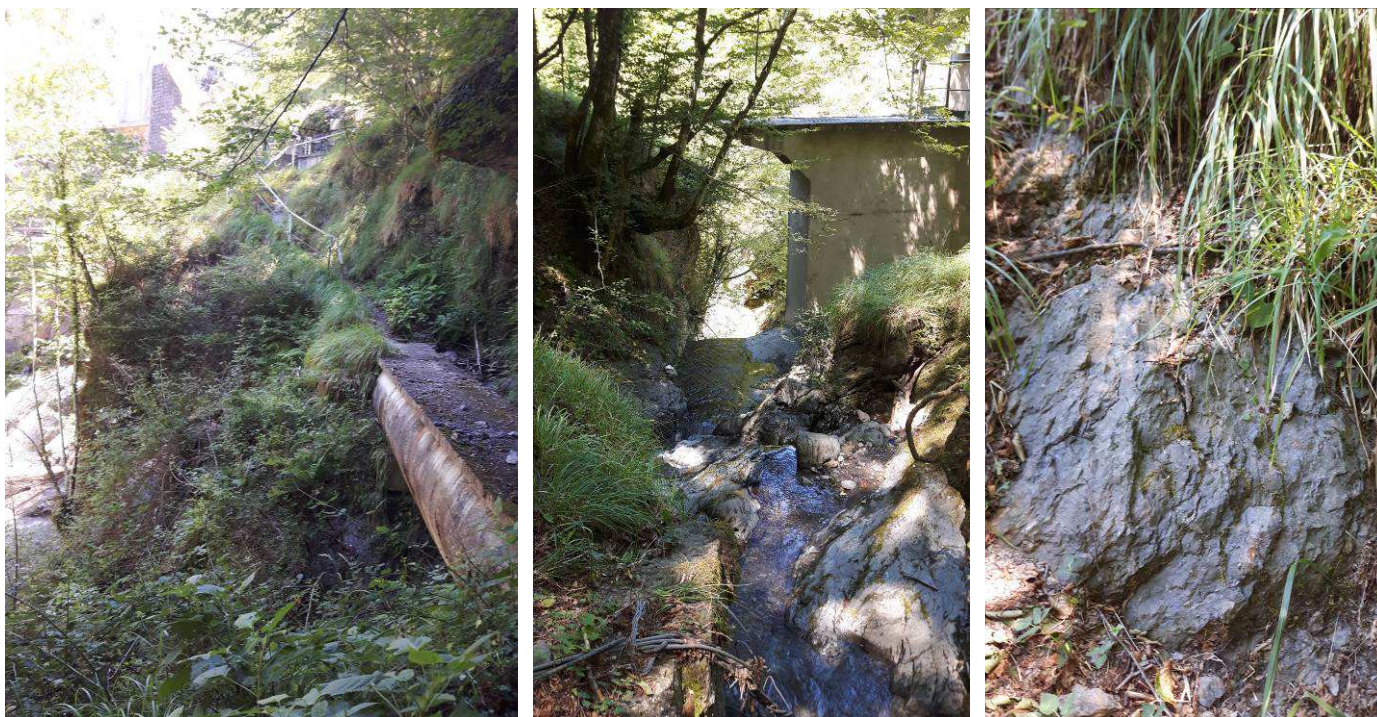
Foto 3 – Affioramento della roccia arenitica sulla spalla sinistra della diga di Zolezzi.
