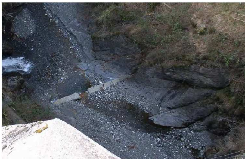
Foto 6 - Affioramento del "Complesso di Casanova" alla base dello sbarramento in sponda sinistra.
