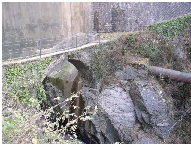
Foto 4 - Affioramenti in sponda sinistra alla base della diga del Complesso di Casanova, in facies arenitica.
