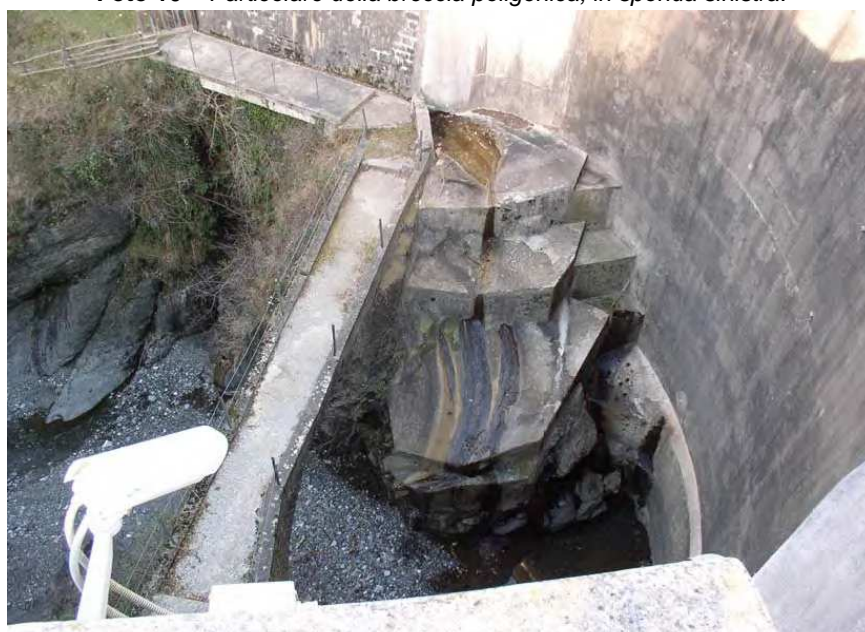
Foto 11 - Affioramenti di arenarie grigio scure in sponda destra alla base della diga.
