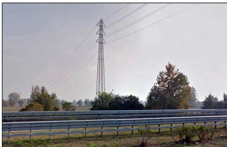
Traliccio del tipo "leggero" a base stretta: particolari costruttivi e fotografia di linea simile già realizzata (in doppia terna, quella in progetto risulta invece in semplice terna quindi ancora meno impattante)
