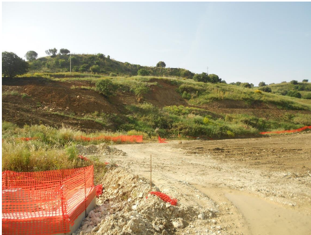
Foto 4: Vista delle scarpate di scavo e del versante di monte 4/4
