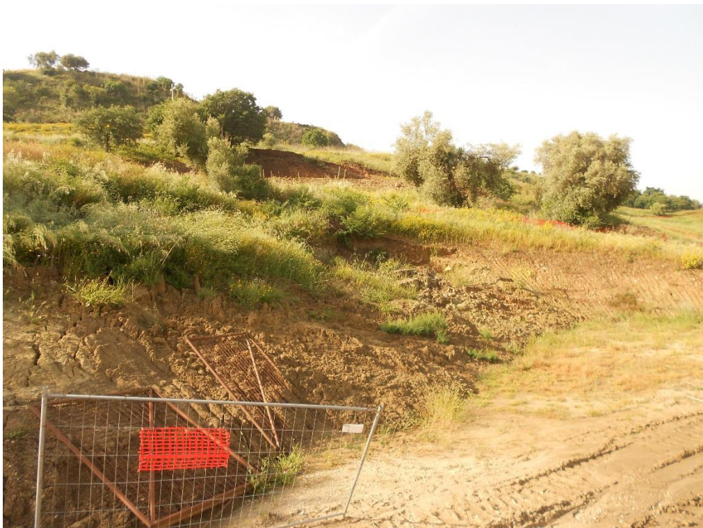
Foto 3: Vista delle scarpate di scavo e del versante di monte 3/4
