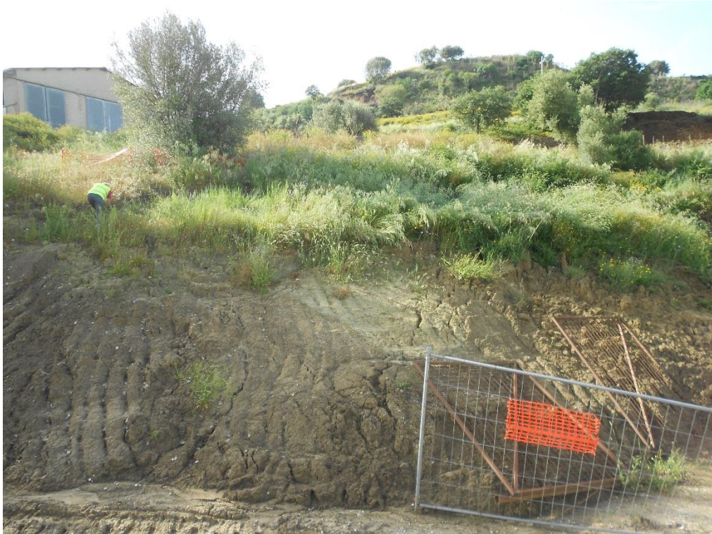
Foto 2: Vista delle scarpate di scavo e del versante di monte 2/4
