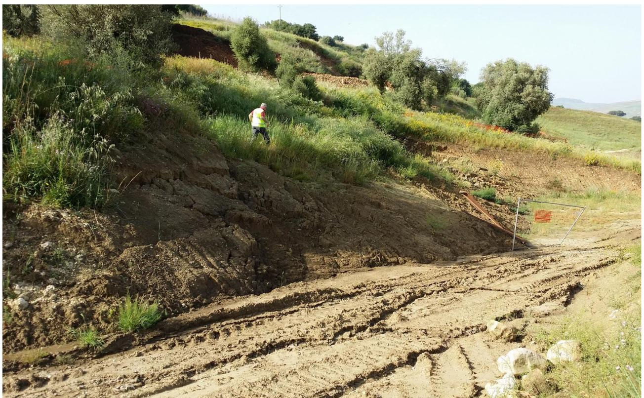
Fig. 2. Fenomeni di instabilità interferenti con i fronti di scavo per la realizzazione della Rotatoria 1.
