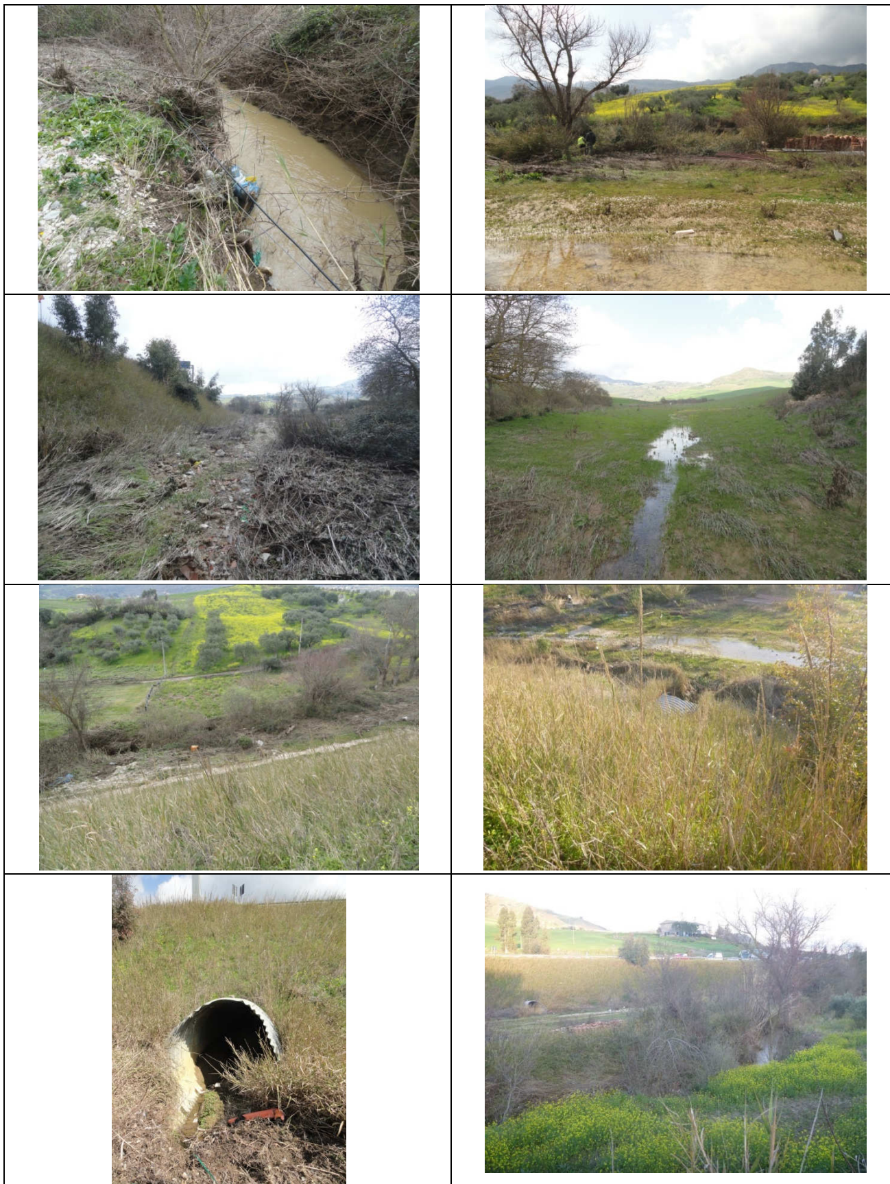
Figura 3 - Immagini Marzo 2015 Svincolo di Mezzojuso LATO VALLE
