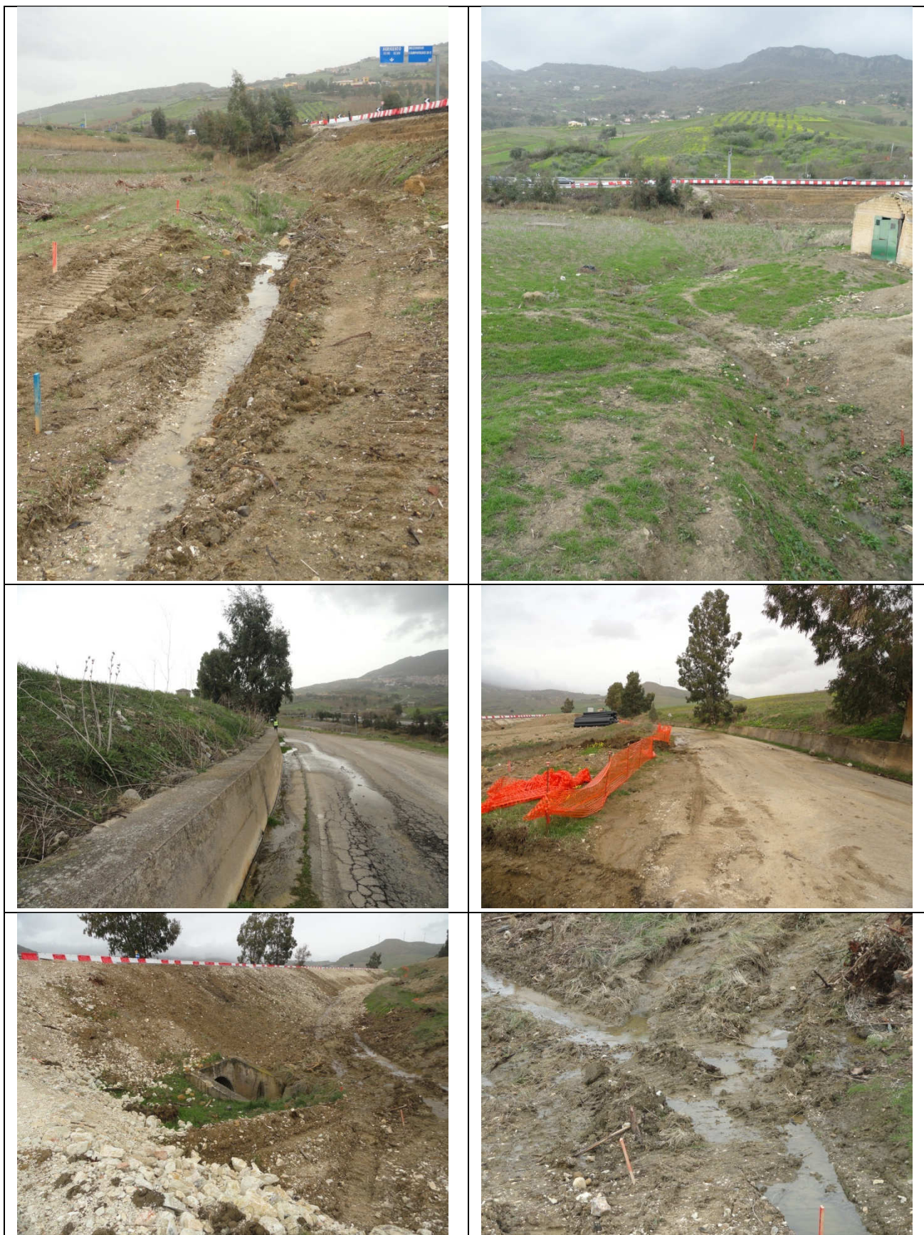
Figura 2 – Immagini Marzo 2015 Svincolo di Mezzojuso LATO MONTE
