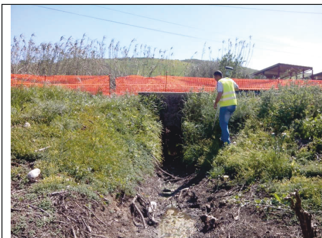
Figura 1 – Sbocco tombino sotto attuale rampa di ingresso dir.AG
