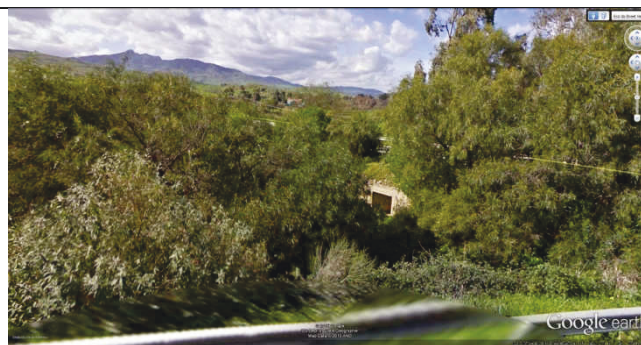
Figura 4-Vista tombino sotto attuale rampa di uscita dir.PA
