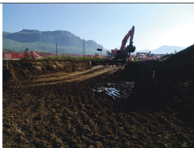
Figura 6 - Venute di acqua da fondo scavo Vicari Nord
