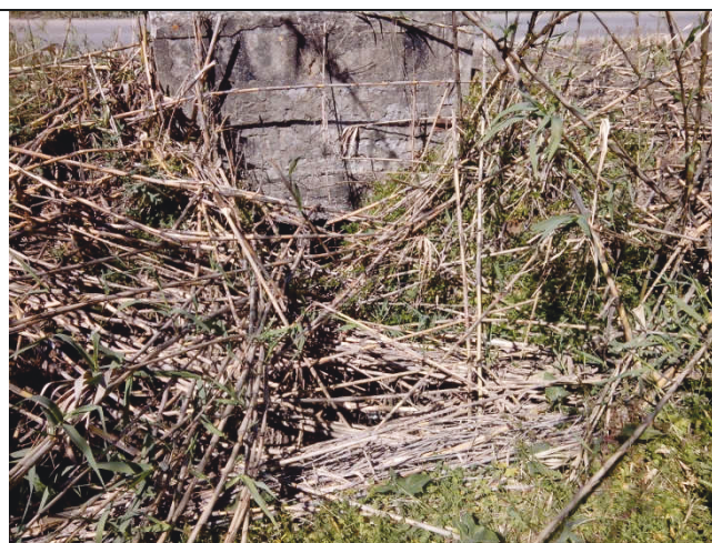
Figura 2 - Imbocco tombino sotto attuale rampa di ingresso dir.AG
