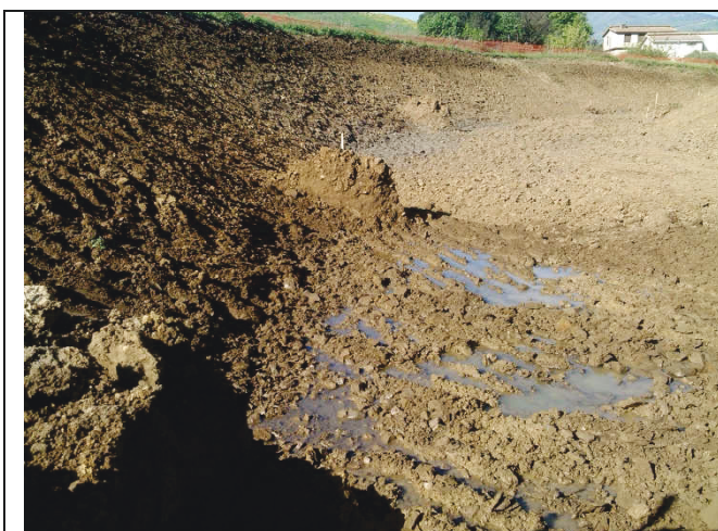
Figura 5 – Venute di acqua da fondo scavo Vicari Nord
