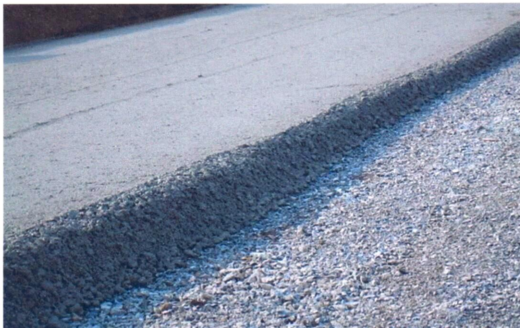
Figura10.4 - Strato finito e compattato del Misto cementato confezionato in Centrale
