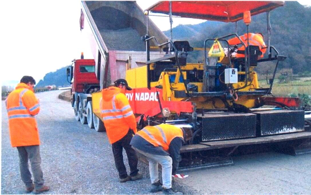
Figura 11.3 - Posa in opera con vibrofinitrice
