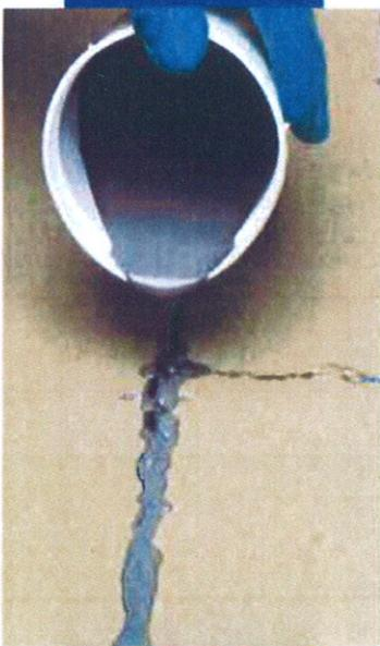
Riparazione crepa di massetto cementizio con Eporip
