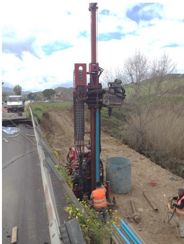
**Foto N°6: Messa in opera del tubo piezometrico**
