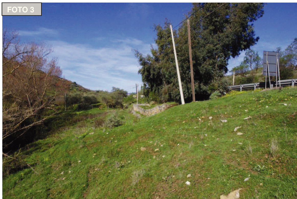
Fig. 5. Foto 3. Evidente l'abbassamento delle gabbionate già presenti sottostrada, manifesta testimonianza che in passato il tratto di strada era già stato oggetto di fenomeni analoghi
