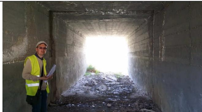
Foto 3: Veduta dell'interno dello scatolare in cui si nota una evidente fessura da cui filtra acqua
