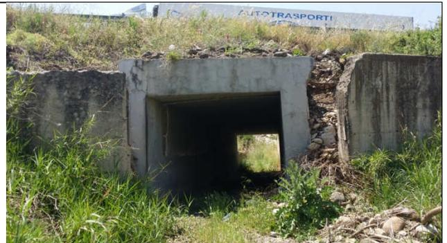
Foto 2: Spostamenti dei muri di estremità dello scatolare esistente
