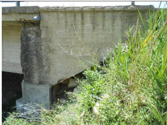
Foto 4: Scalzamento della spalla del viadotto
