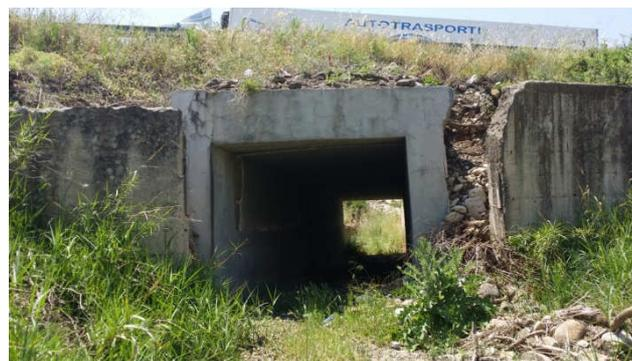
*Fig. 10. Spostamenti dei muri di estremità dello scatolare esistente*
