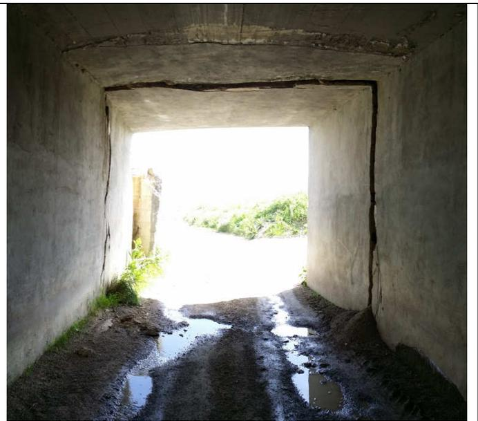
Fig. 19. Fessura interna allo scatolare
