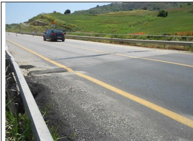
*Fig. 9. Abbassamento del piano viario*
