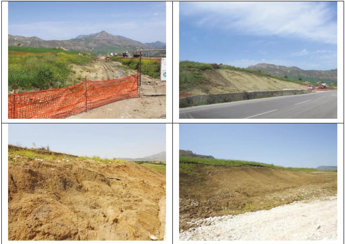
Fig. 2. Fenomeni di instabilità sulle scarpate di scavo.
