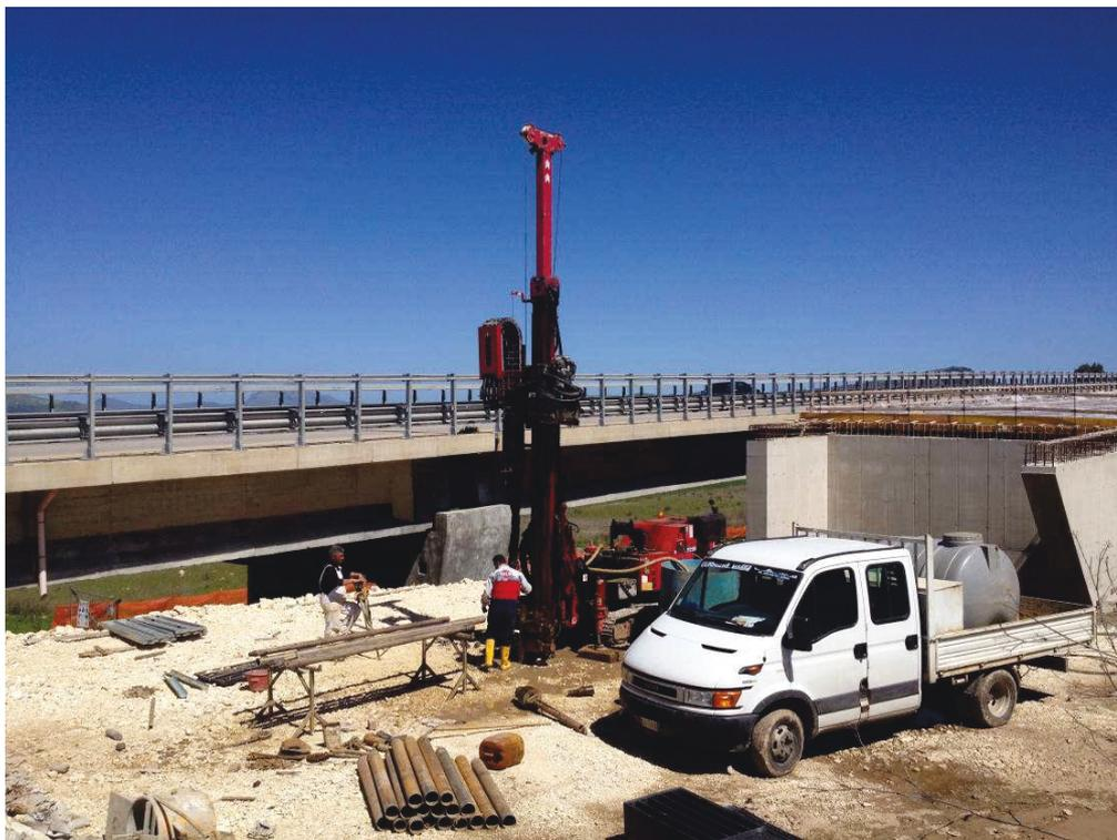
Foto della sonda durante esecuzione del sondaggio
