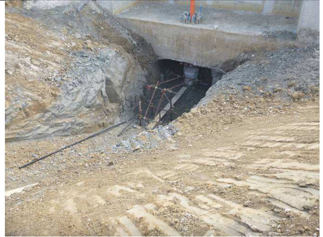
Figura 8_ Vista scavo per prove di carico su spalla 1
