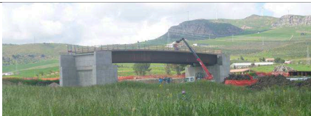
Figura 4_Vista CV04 in costruzione
