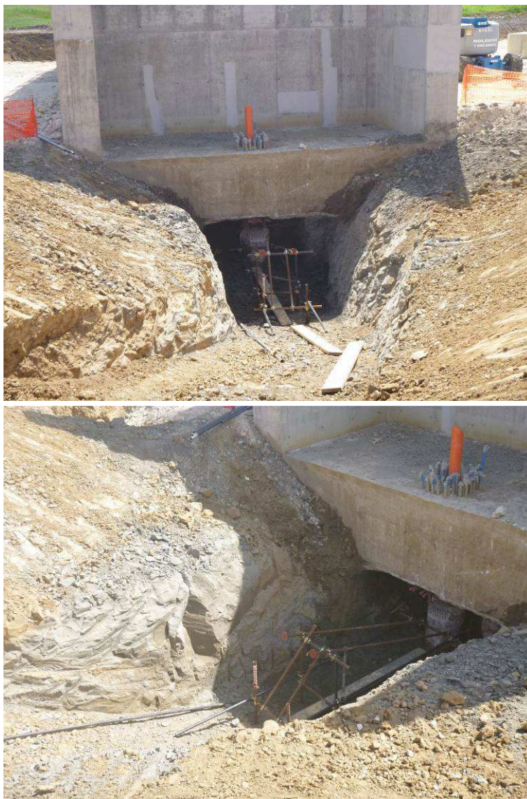
Figura 9. Foto dello scavo operato a tergo della spalla per esecuzione della prova di carico
