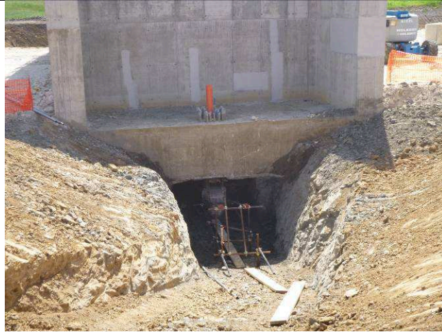
Figura 7_ Vista scavo per prove di carico su spalla 1
