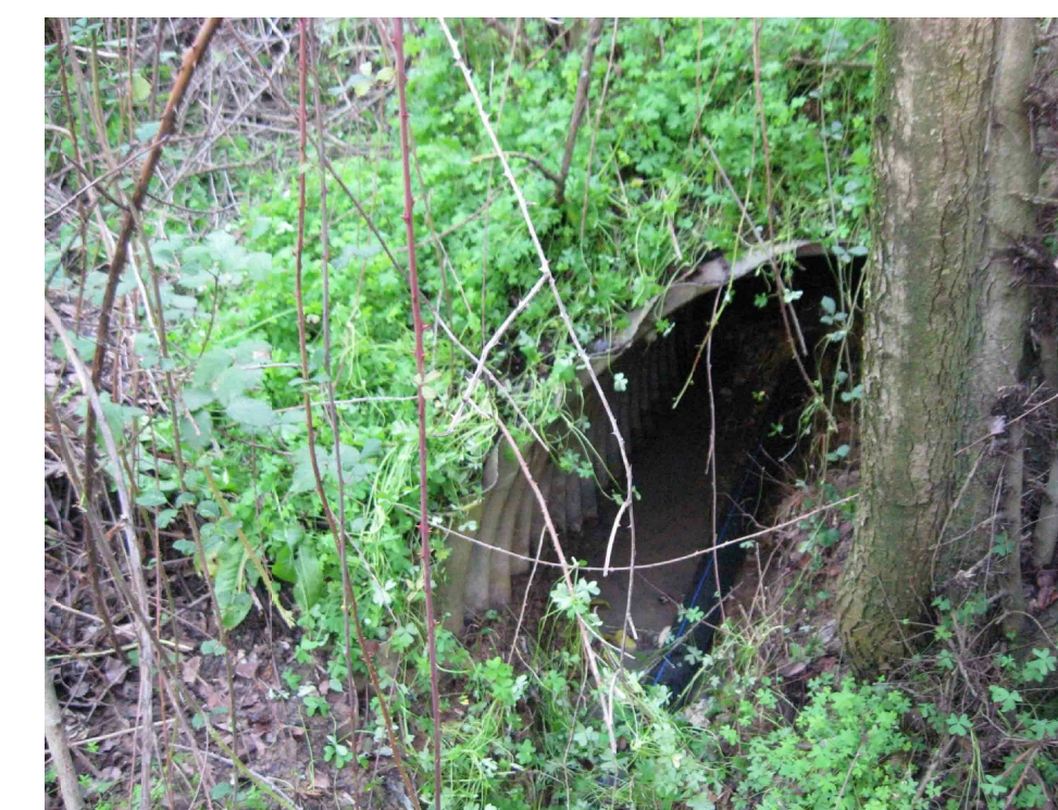
Manufatto di sbocco
