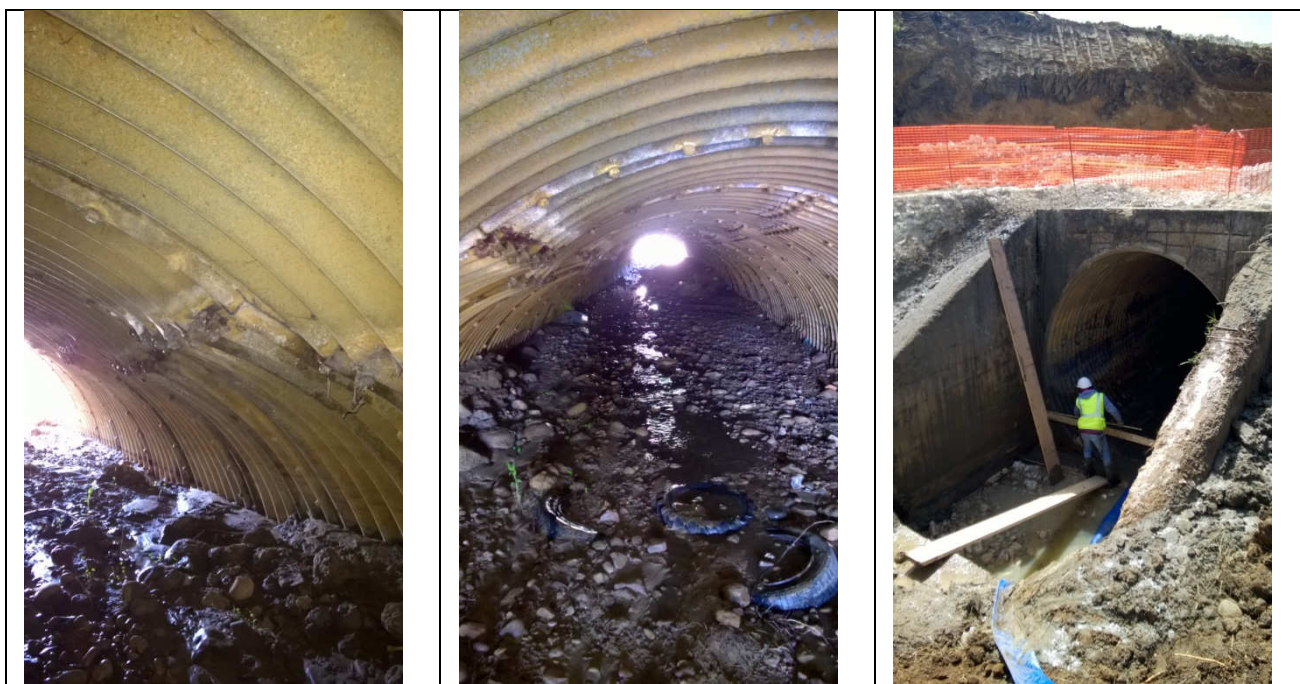
Figura 1 – Foto di cantiere tombino TP27
