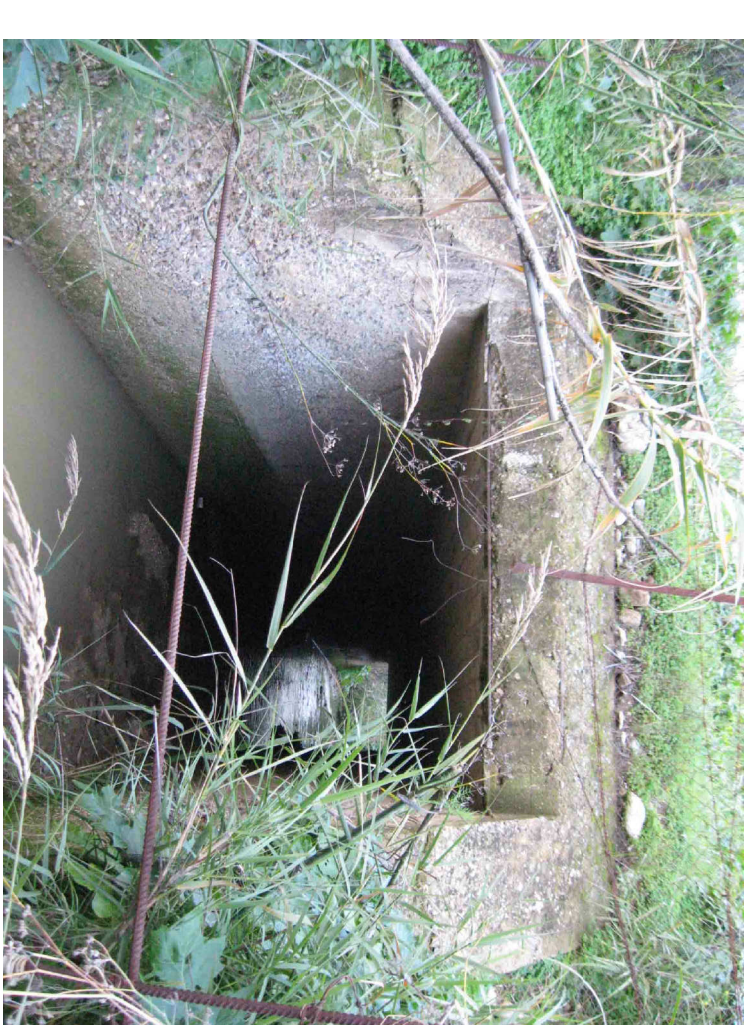
Manufatto di sbocco
