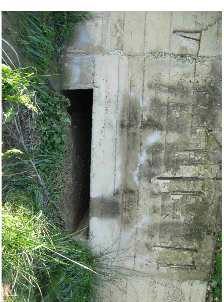
Manufatto di sbocco
