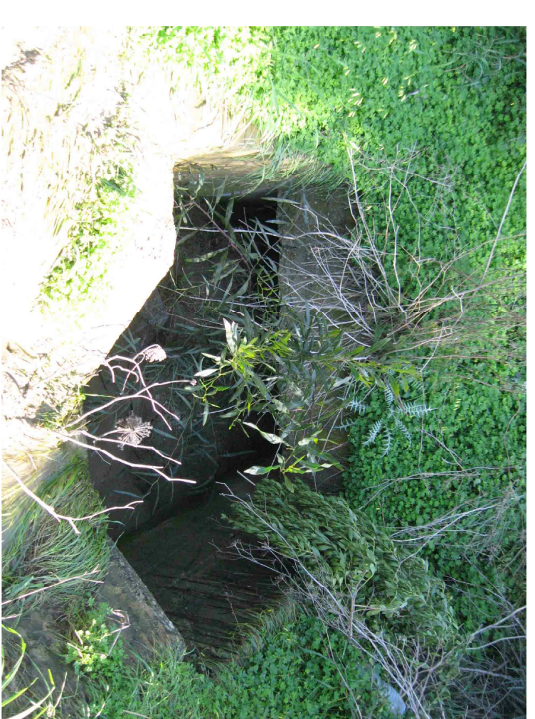
Manufatto di imbocco
