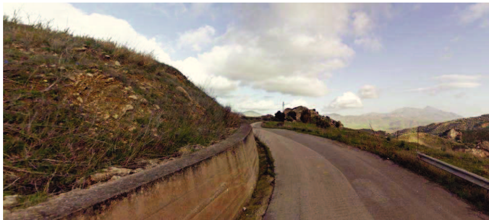
Figura 15. La viabilità secondaria per Casa Tani Japico, con muri di contenimento in c.a. e in alcuni tratti i segni di dissesti idrogeologici.
