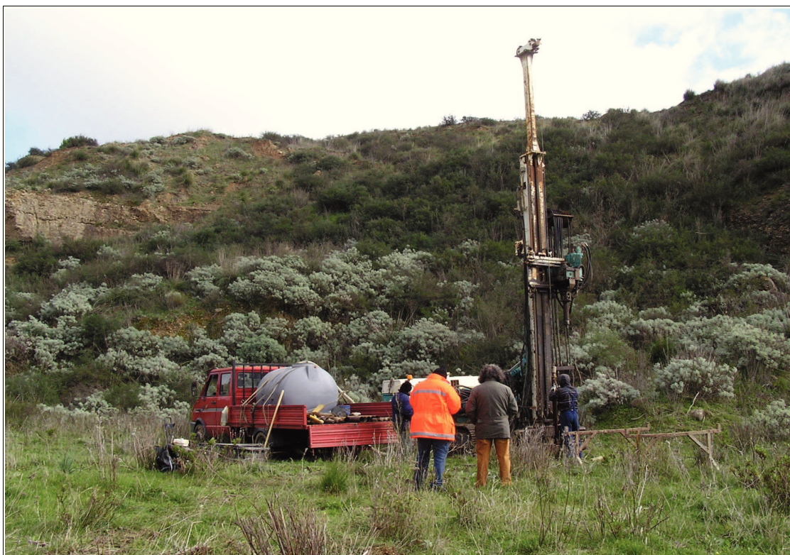
Fig. 1 – Sondaggio geognostico a carotaggio continuo; fase iniziale dei lavori.
