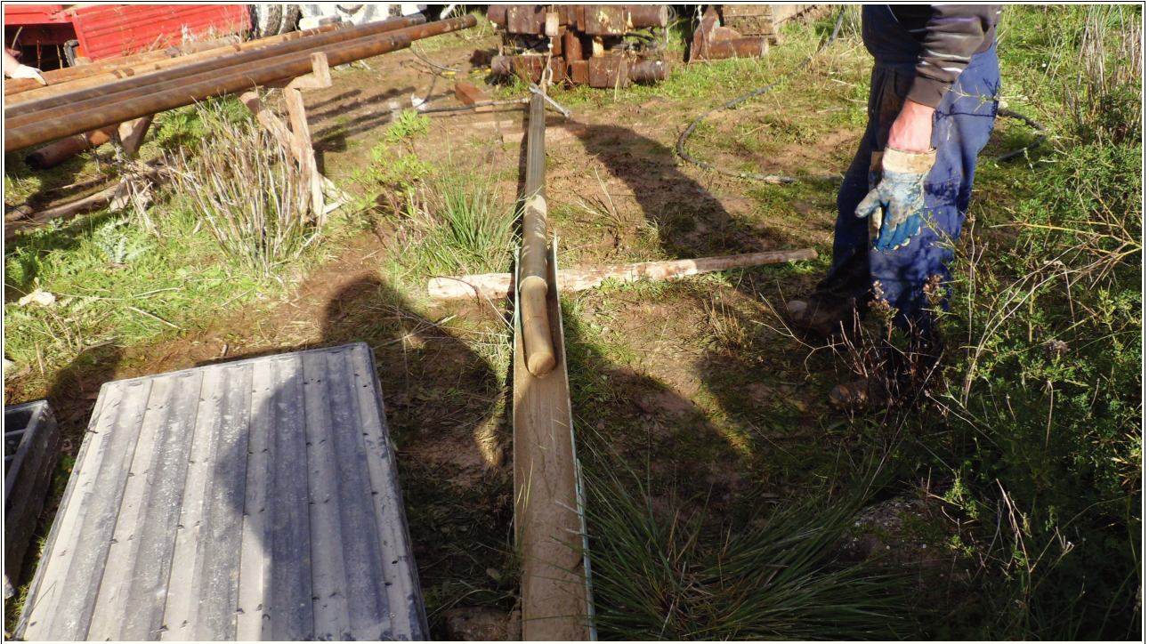
Fig. 2 – Sondaggio geognostico a carotaggio continuo; fase di estrazione della carota.
