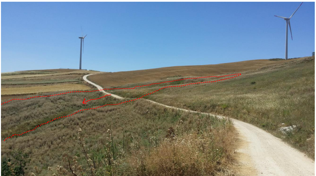
Figura 5: Dissesto in corrispondenza della carrareccia al limite Sud-Ovest dell'area di intervento.
