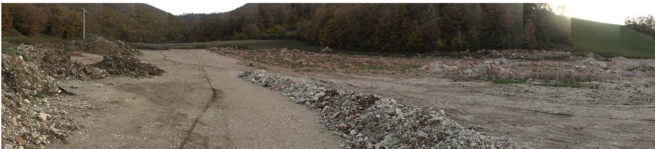
Figura 6.c - Immagine dell'area in fase di cantiere
