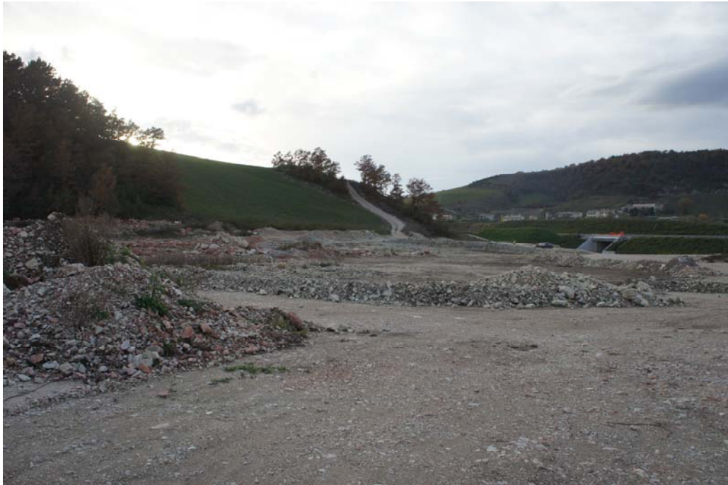
Figura 6.b - Immagine dell'area in fase di cantiere
