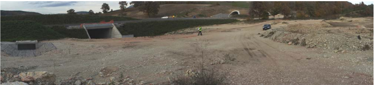
Figura 6.a - Immagine dell'area in fase di cantiere
