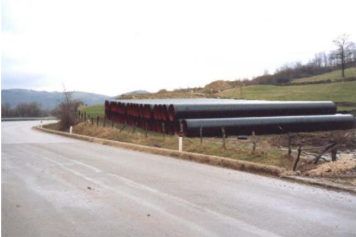
Figura 3.b: Piazzole di stoccaggio tubazioni
