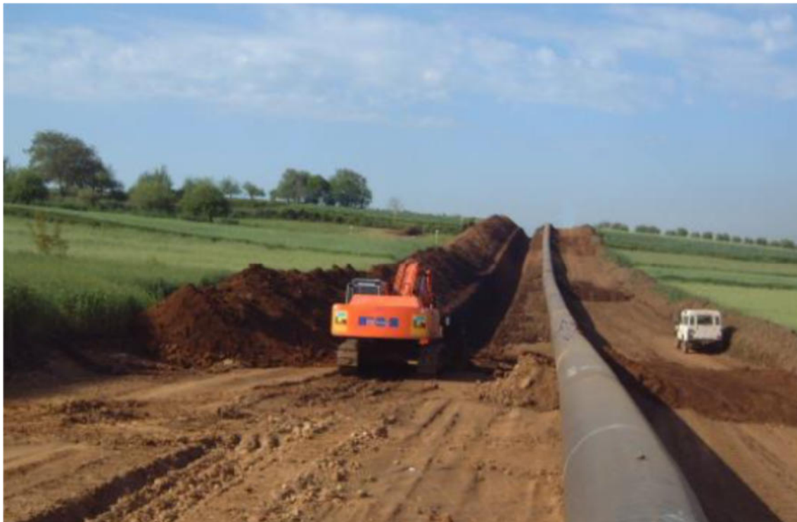
Figura 3.d: Scavo della trincea
