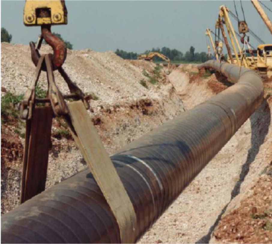
Figura 3.e: Posa tubazione
