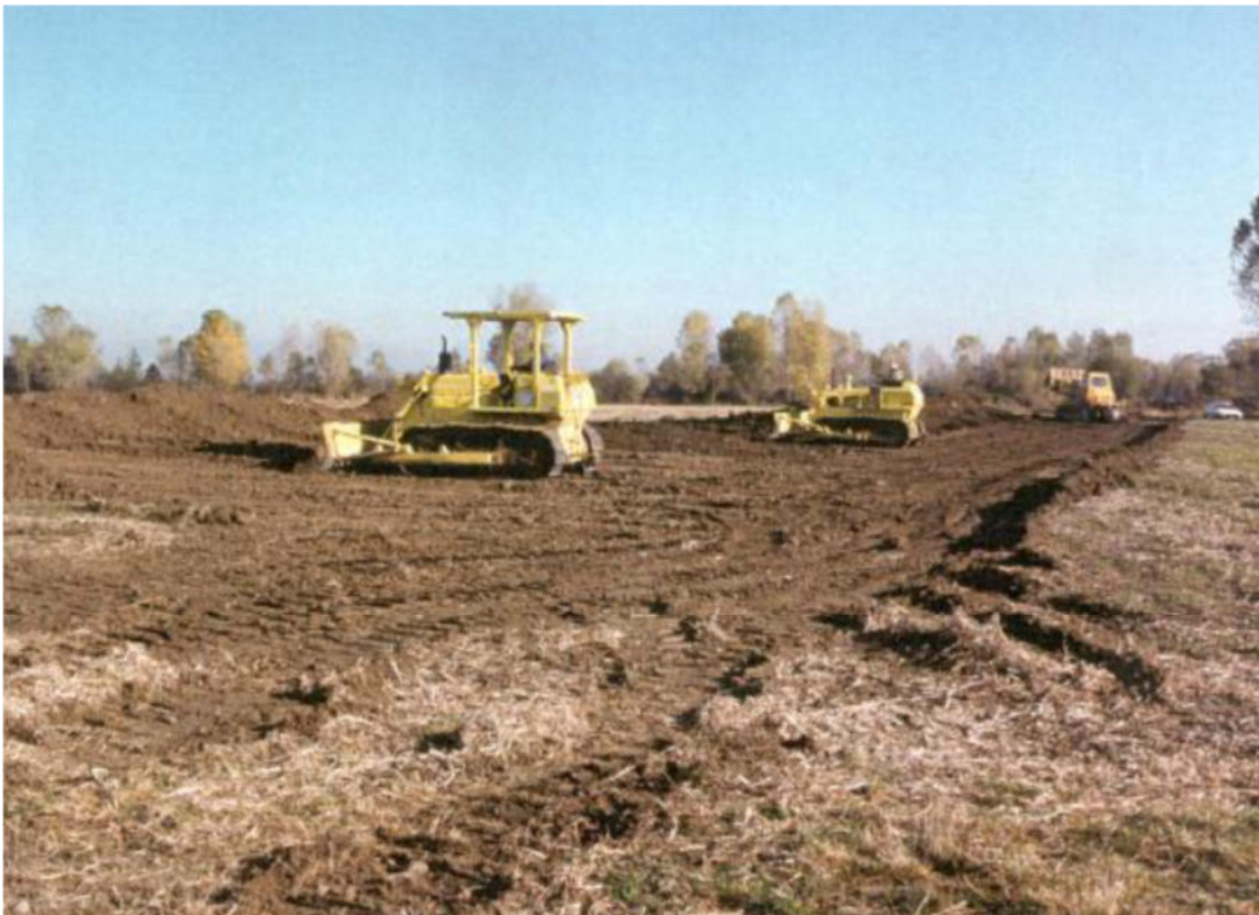
Figura 3.c: Apertura fascia di lavoro
