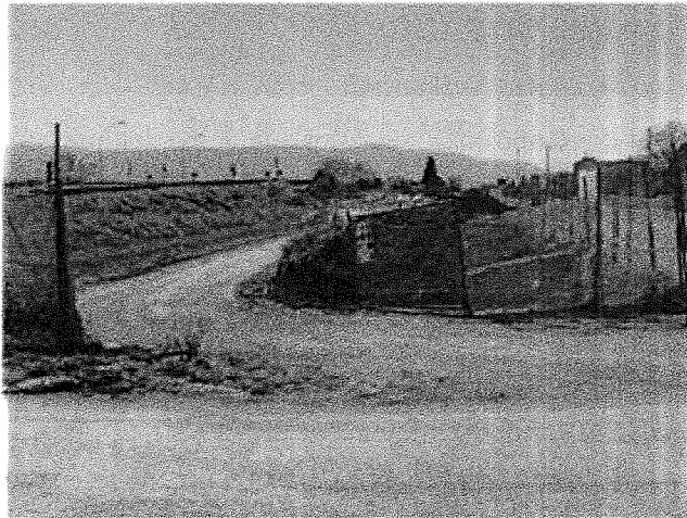
Foto 1 Ingresso cantiere - Area Est
