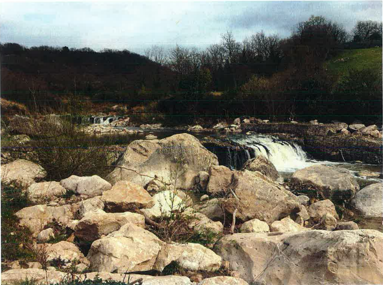
Figura 22 – Torrente Ufita nei pressi del viadotto VI02
